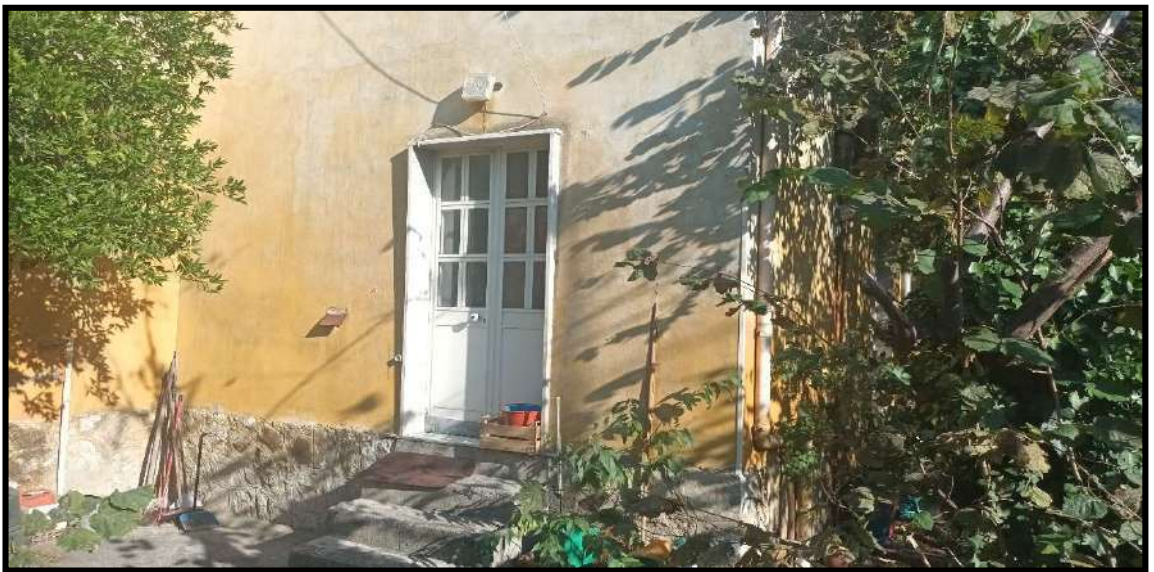
Foto 5 Vista Facciata laterale dalla corte
