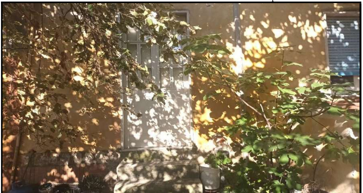
Foto 9 Vista Facciata laterale dalla corte
