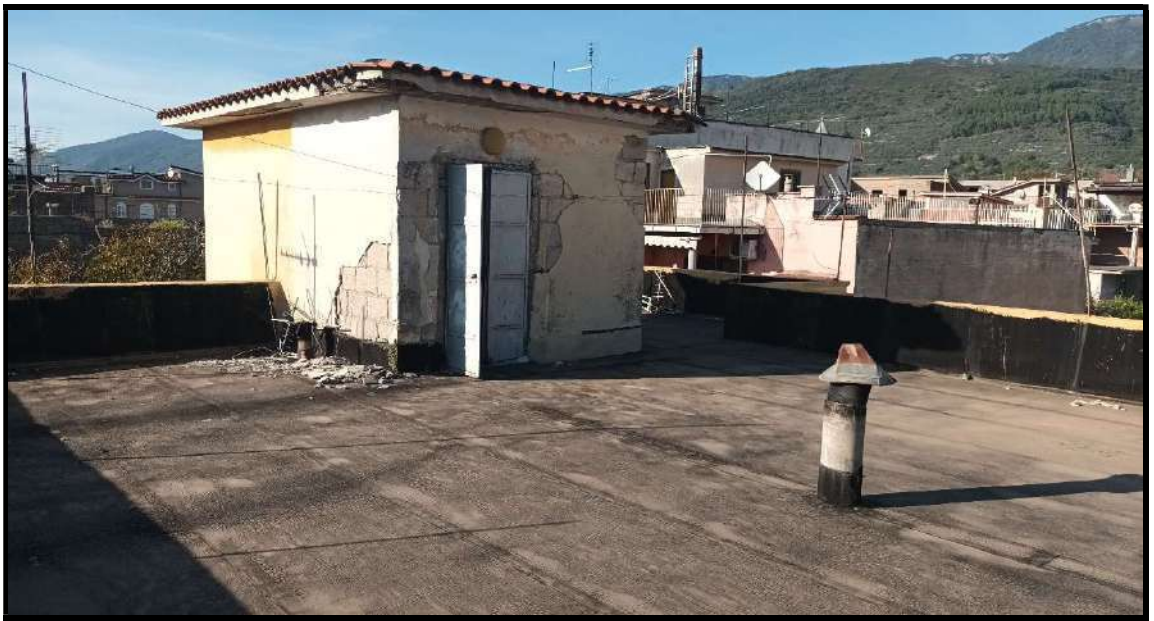
Foto 27 Vista del lastrico solare
