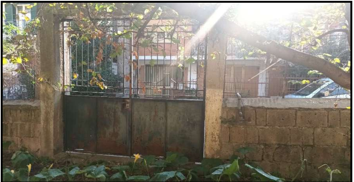
Foto 6 Vista Ingresso posteriore dalla corte
