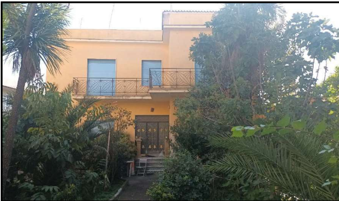
Foto 3 Vista Facciata principale dalla corte
