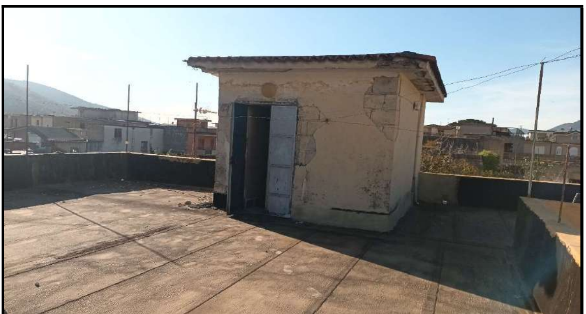
Foto 26 Vista del lastrico solare
