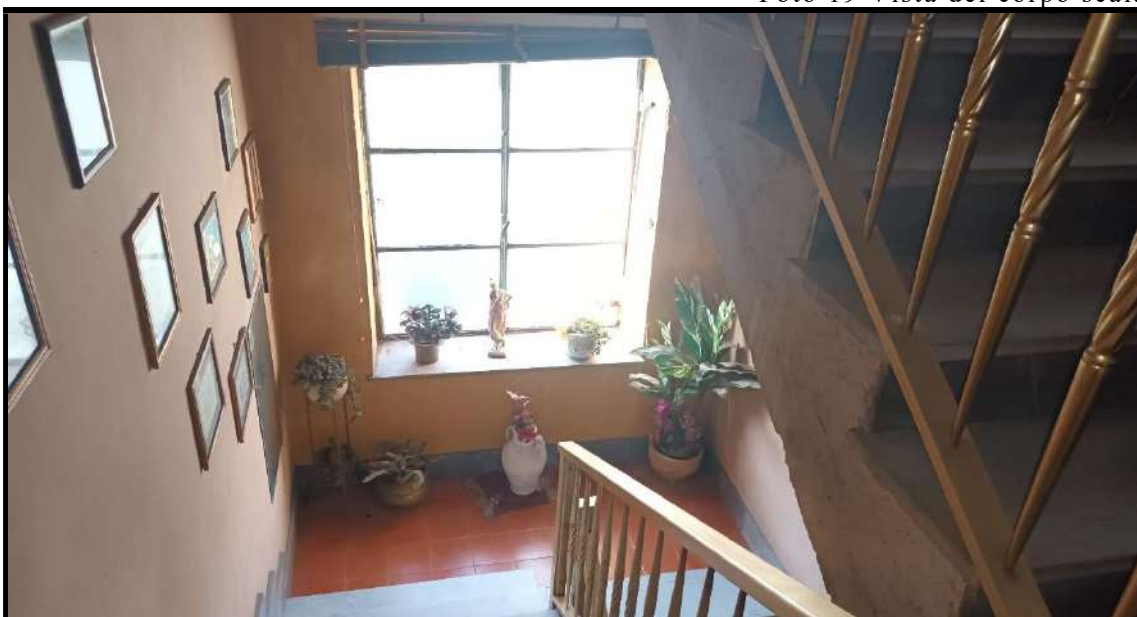
Foto 20 Vista del corpo scala
