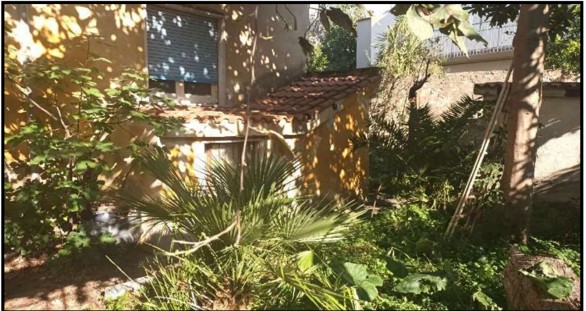
Foto 8 Vista Facciata posteriore dalla corte
