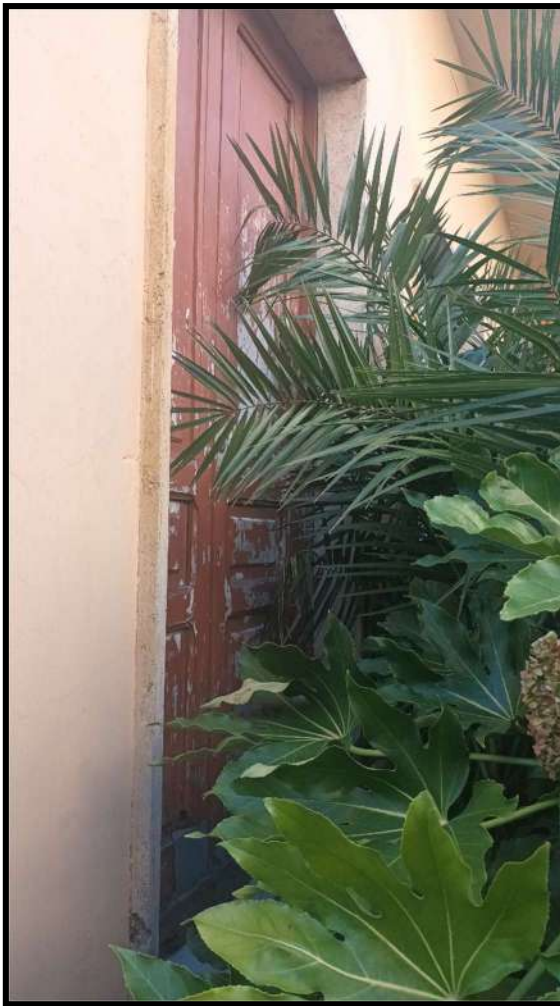
Foto 10 Vista Facciata laterale dalla corte
