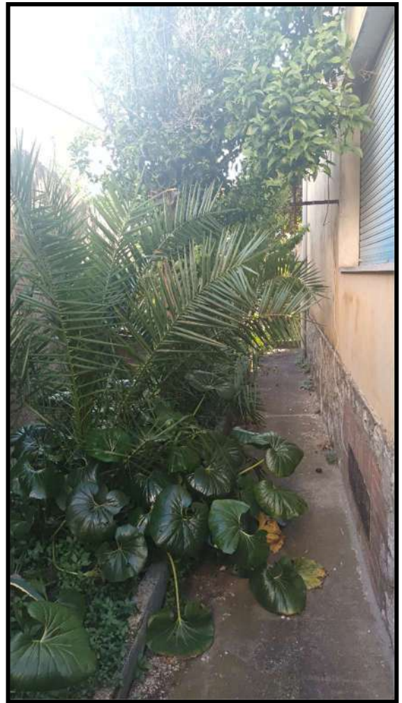
Foto 11 Vista Facciata laterale dalla corte
