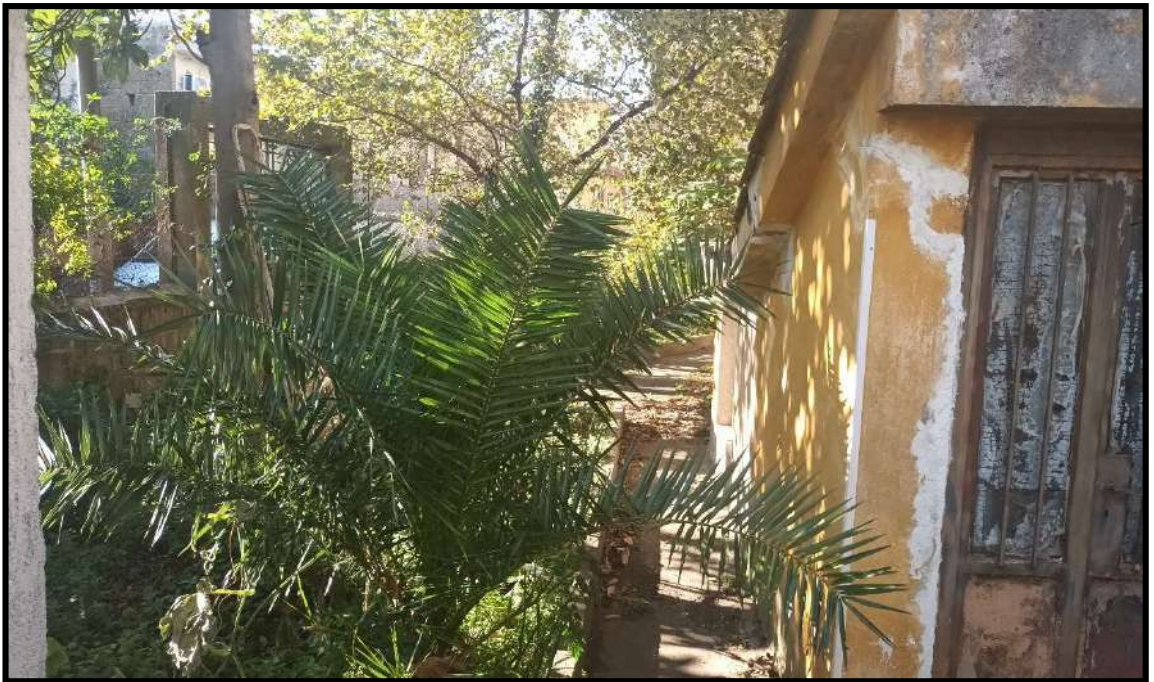
Foto 7 Vista Facciata posteriore dalla corte
