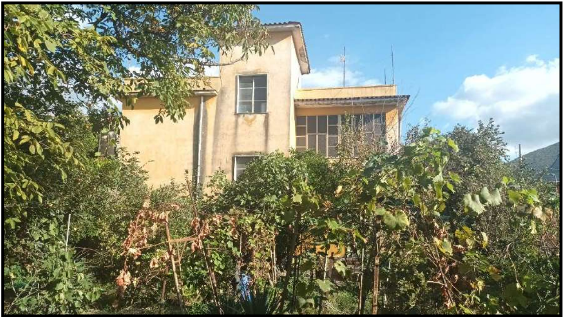
Foto 4 Vista Facciata laterale dalla corte
