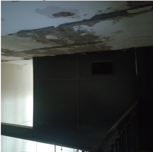
Foto n. 9 – Degrado del soffitto del vano scala
