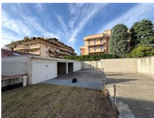
Vista del cortile e del corpo a box-autorimesse realizzato sulla particella 811
