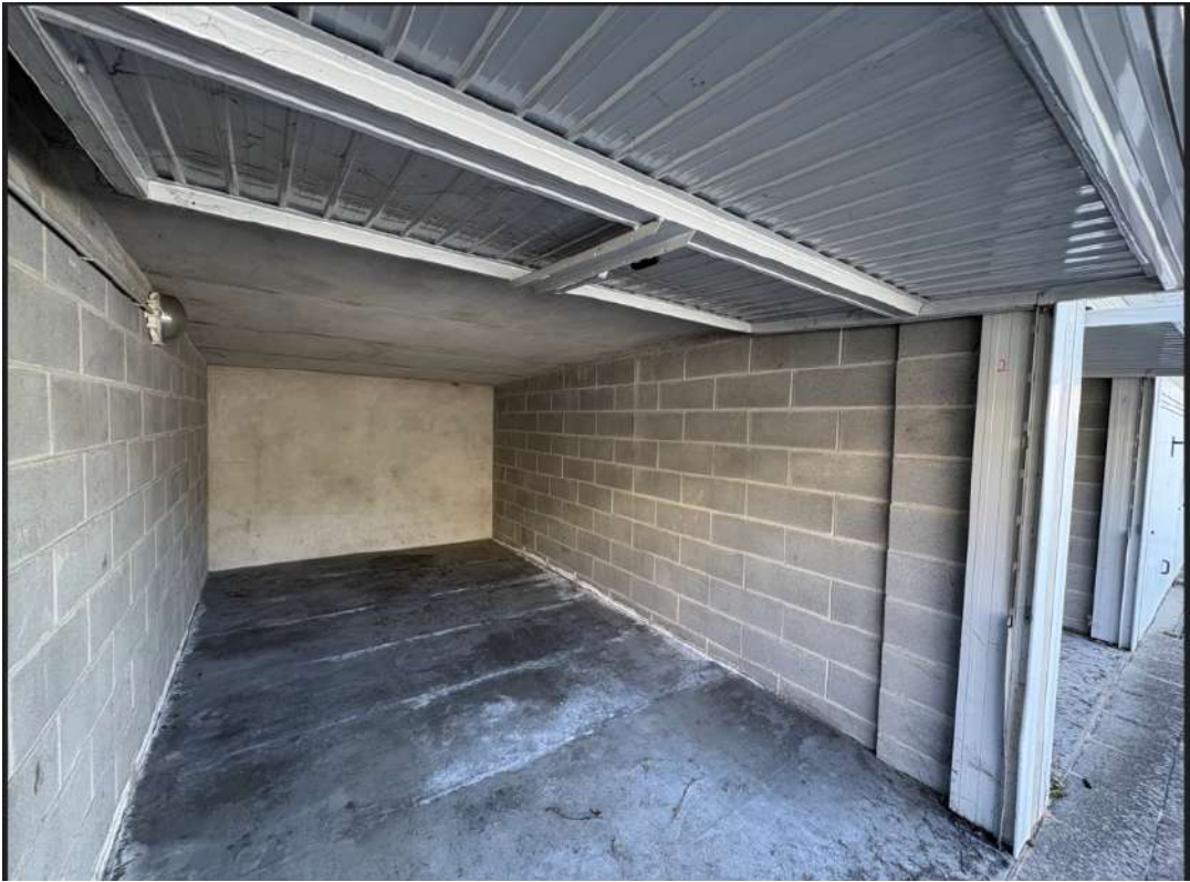
Box tipo del corpo particella 811
