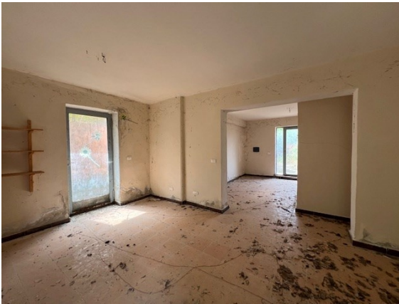
Vista interno P.T. terra fg. 4 p.la 1257 sub 3
