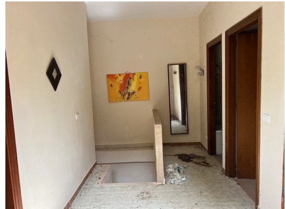
Vista interno 1°P. fg. 4 p.la 1257 sub 3
