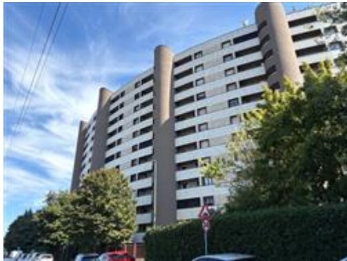
Vista del corpo A
