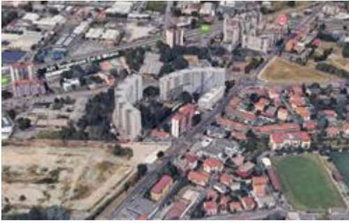
Vista satellitare del complesso residenziale
