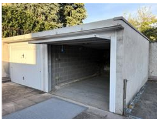
box - autorimessa sub 701
