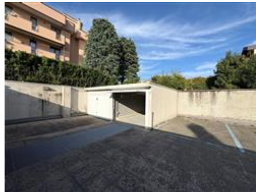
vista del corpo a due box realizzati sulla particella 812
