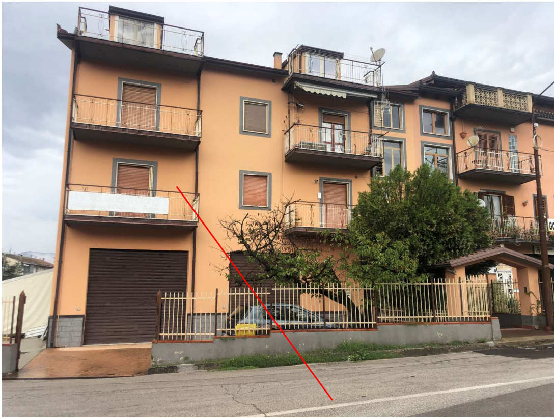
Prospetto su via Serra del Mulino - Appartamento oggetto di stima
