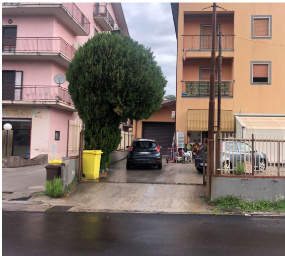
Cancello di accesso al piazzale
