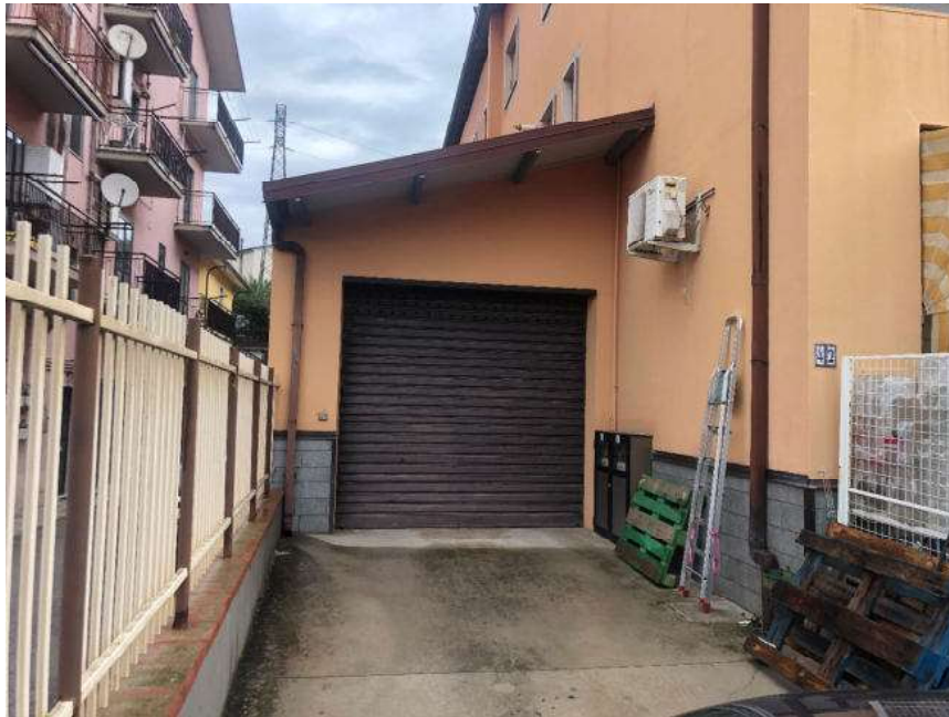
Porta di accesso al Box
