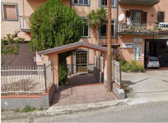
Ingresso al fabbricato
