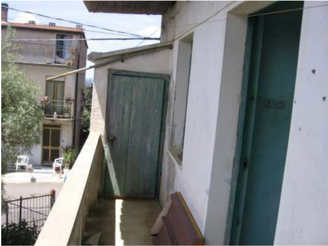
LOTTO_1 – bagno esterno
