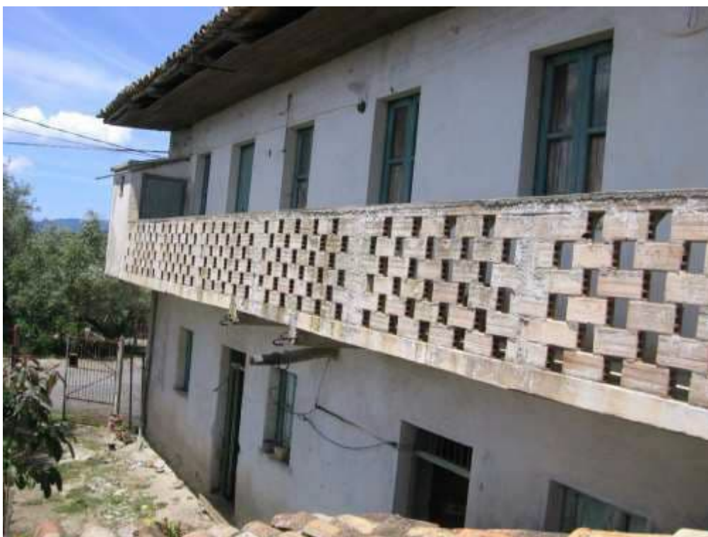
LOTTO_1 – prospetto principale fabbricato
