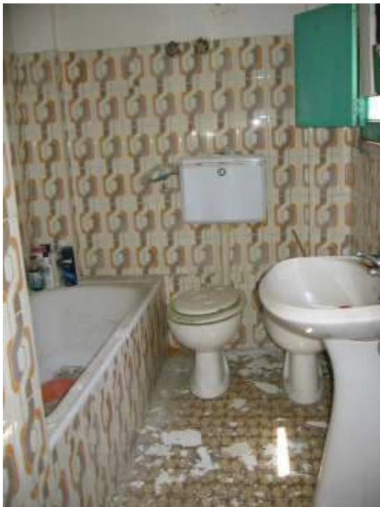
LOTTO_1 – bagno interno
