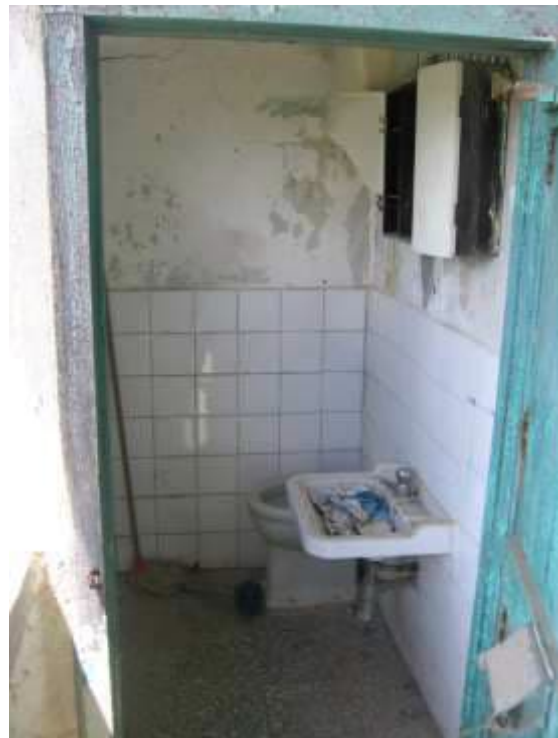
LOTTO_1 – bagno esterno
