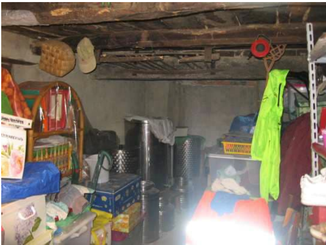
LOTTO_4 – vano PT
