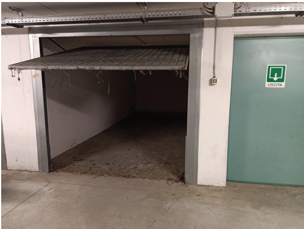
Foto n. 4 – Piano interrato – Autorimessa LOTTO n. 5
