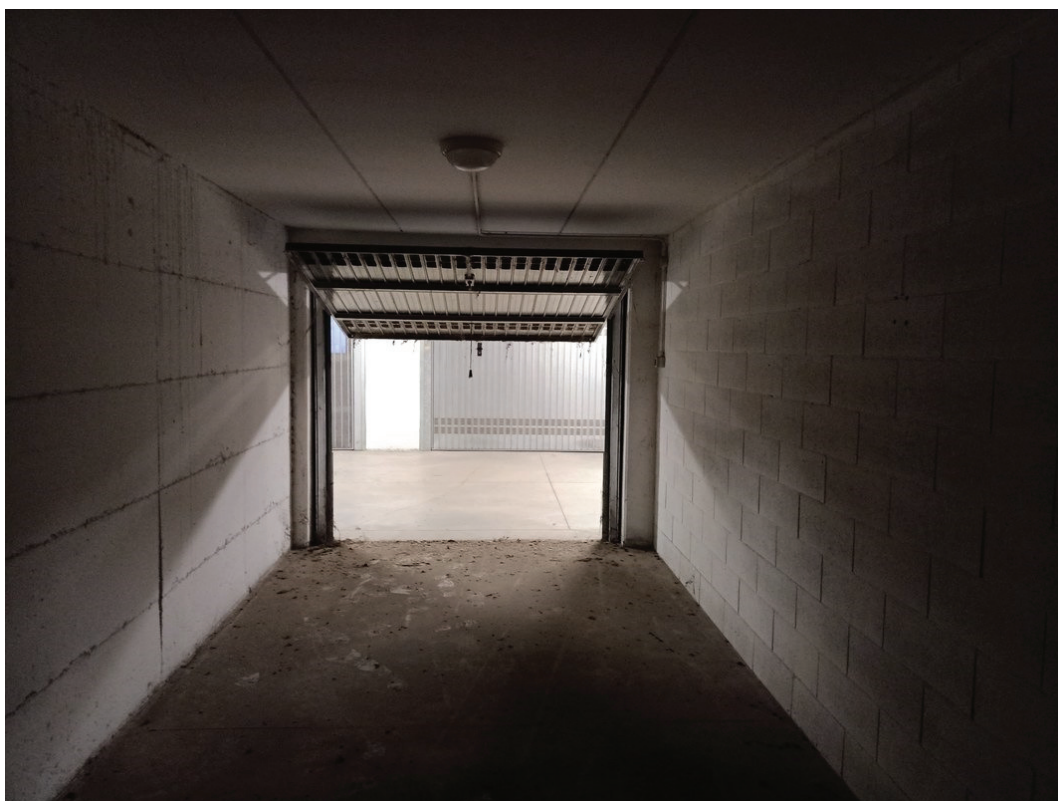
Foto n. 5 – Piano interrato – Autorimessa LOTTO n. 5
