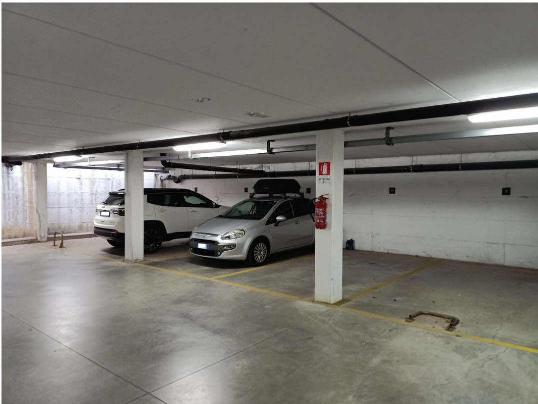
Foto n. 9 – Piano interrato – Posti auto LOTTI n. 11, n. 12, n. 13, n. 14 e n. 15
