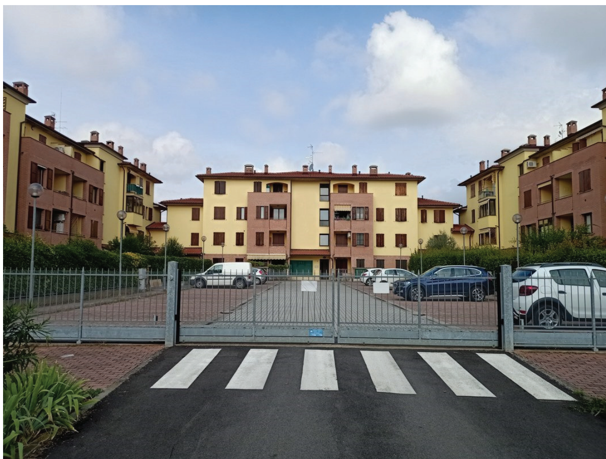
Foto n. 1 – Vista esterna del fabbricato condominiale
