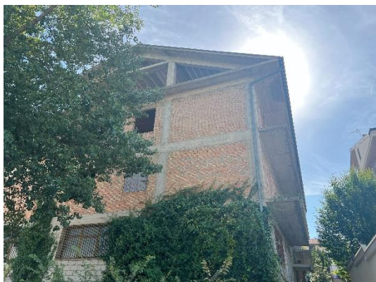
FRONTE NORD - OVEST
