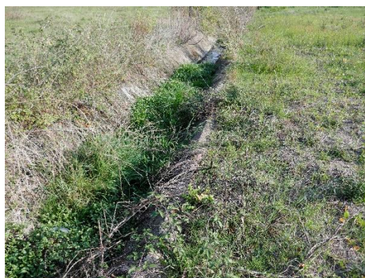
FOSSO DI SCOLO CONFINE EST
