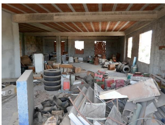
PIANO SECONDO - IN COSTRUZIONE
