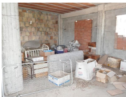
PIANO SECONDO - IN COSTRUZIONE
