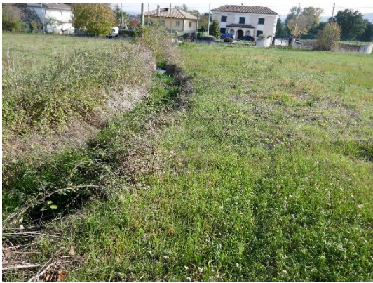
FOSSO DI SCOLO CONFINE EST
