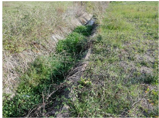
FOSSO DI SCOLO CONFINE EST
