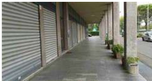
particolare del portico del condominio
