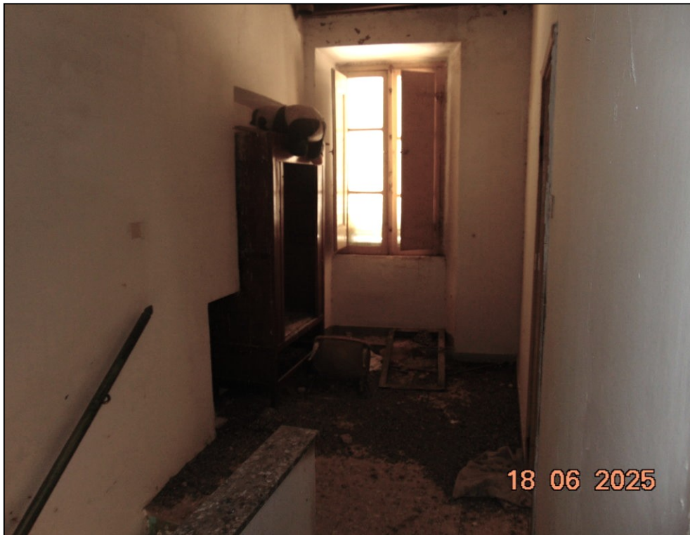
Figura 14 – Visuale interna disimpegnato piano secondo
