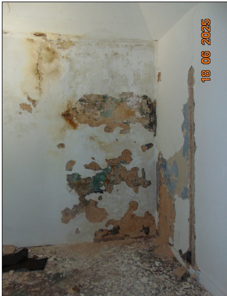
Figura 16 – Dettaglio pareti camera n.1
