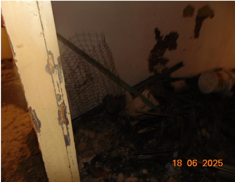
Figura 19 - Visuale interna camera n.2
