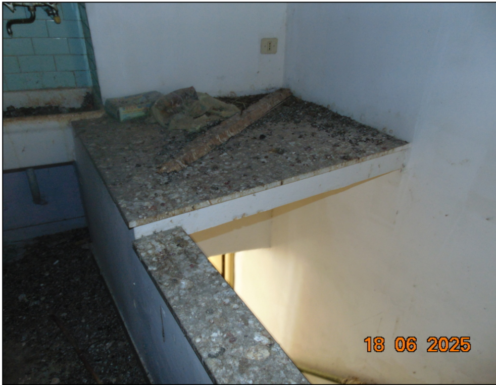
Figura 15 – Dettaglio solaio copertura parziale scale
