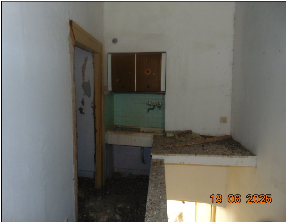
Figura 13 – Visuale interna disimpegnato piano secondo
