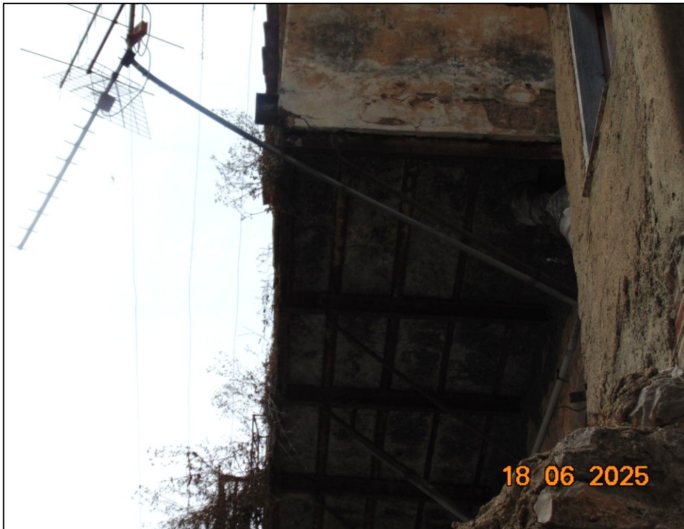
Figura 20 – Dettaglio del solaio in ferro del terrazzo-bagno
