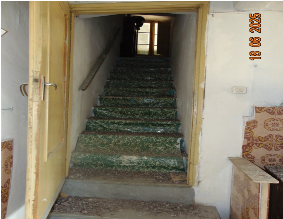
Figura 12 – Scala di collegamento tra il piano primo ed il piano secondo
