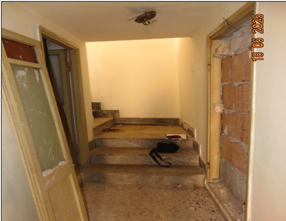
Figura 8 - Visuale interna dell'ingresso-vano scala al piano terra
