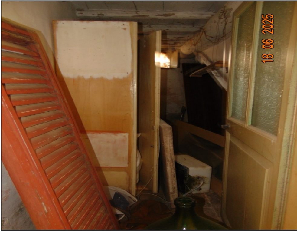
Figura 7 - Visuale interna del ripostiglio al piano terra
