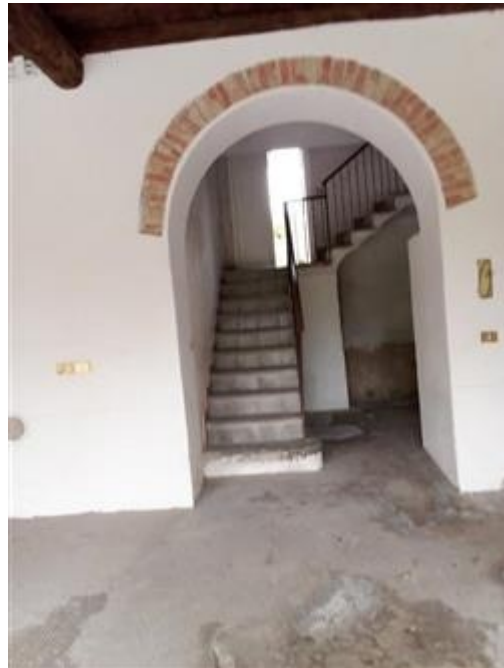
ingresso scale dal portico
