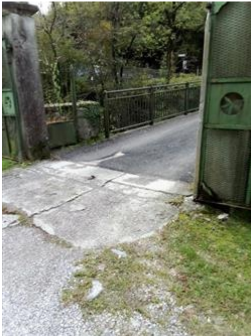
cancello d'ingresso dal ponte
