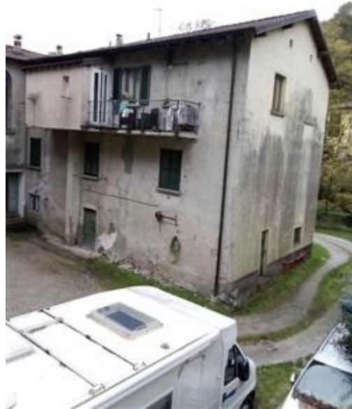
fabbricato lato N - E
