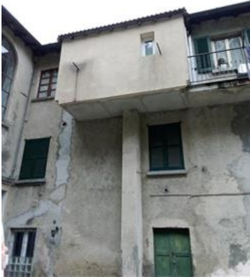
fabbricato lato posteriore
