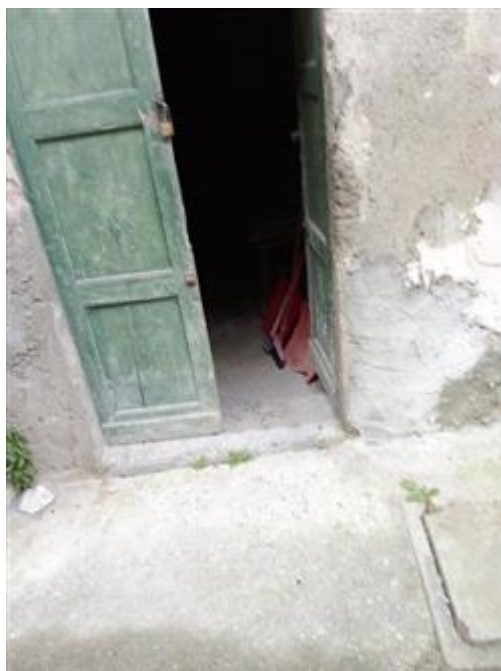
accesso alla cantina
