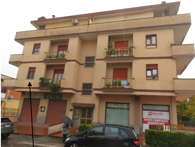
Prospetto su Via L. da Vinci 48
