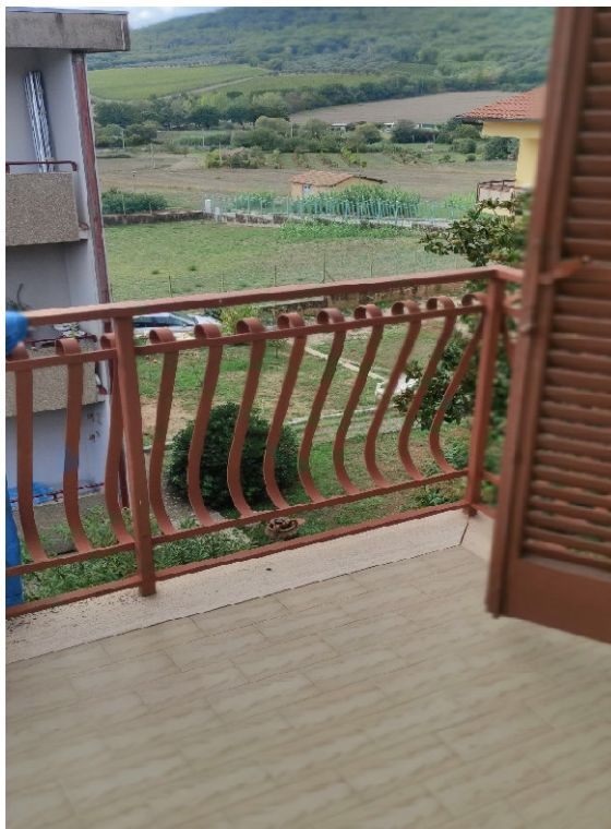
Particolare dei balconi di pertinenza delle camere del BENE A
