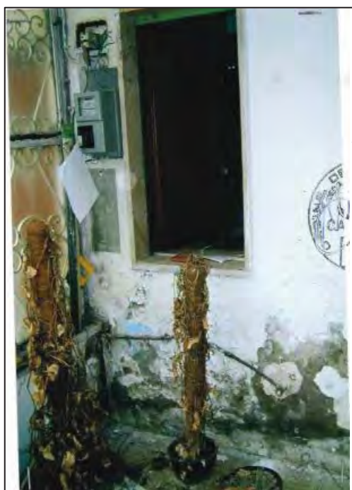
Finestra interna tamponata
