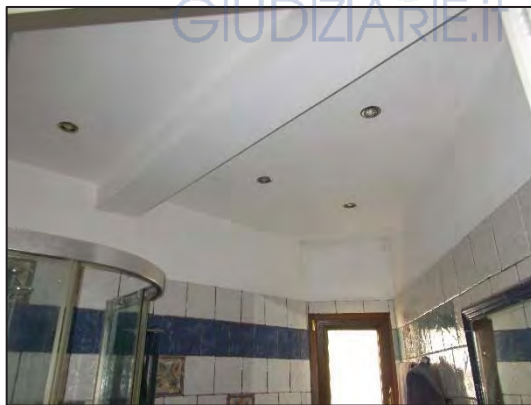
Viste del bagno di servizio
