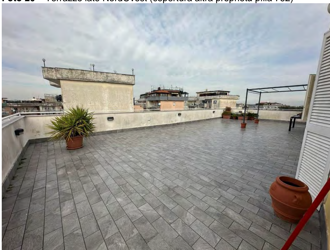
Foto 21 – Terrazzo lato NordOvest (copertura altra proprietà p.Ila 762)
