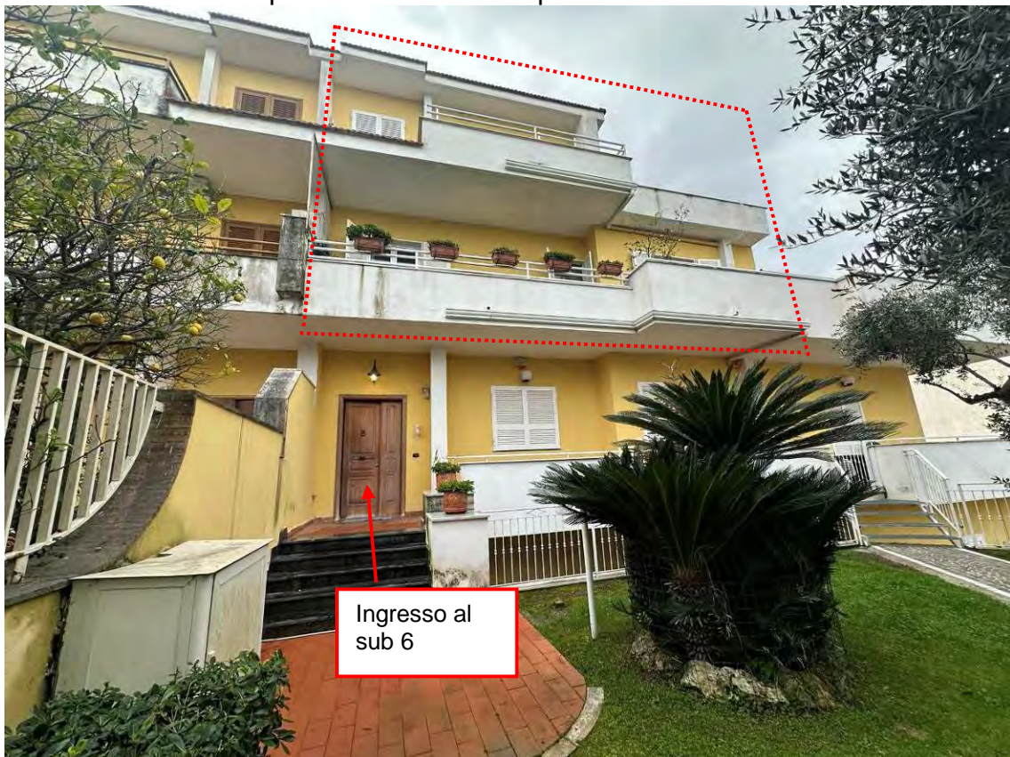
Foto 06 – Il fabbricato ed individuazione del sub 6
