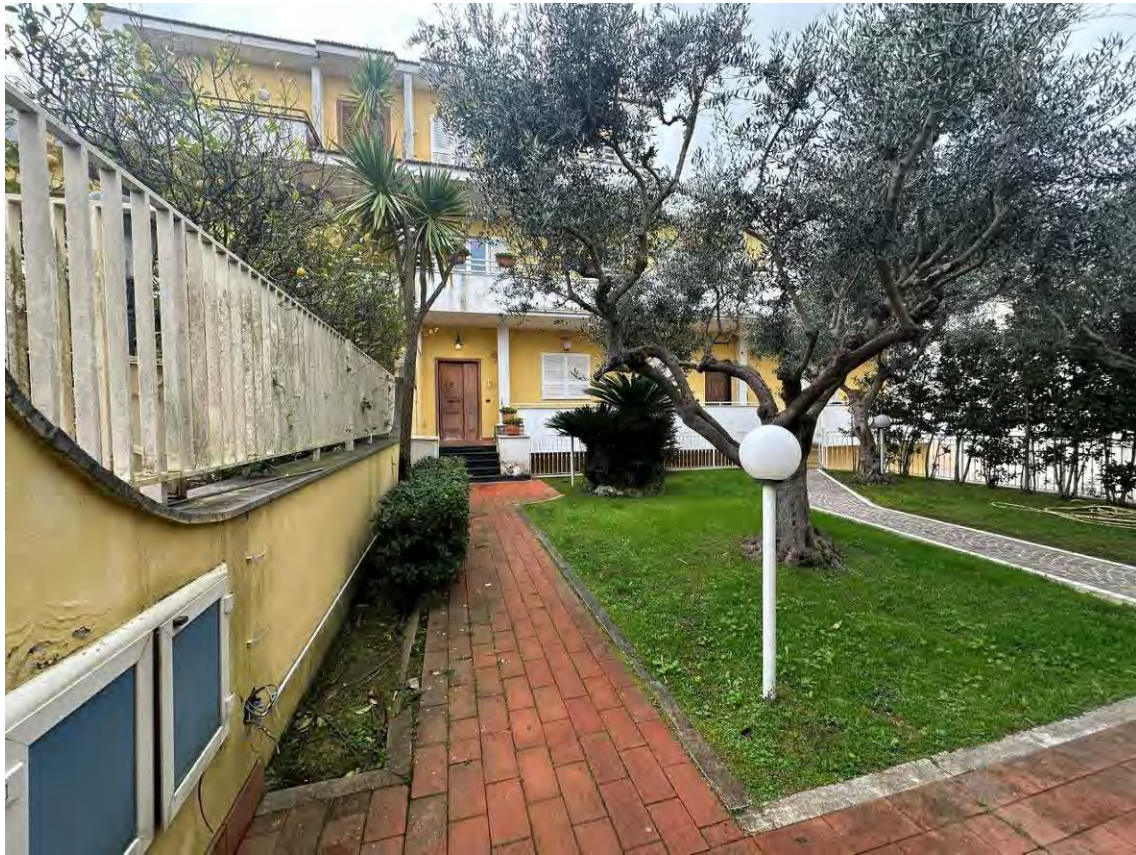
Foto 05 – L'area scoperta comune sub 1- p.IIa 1018
