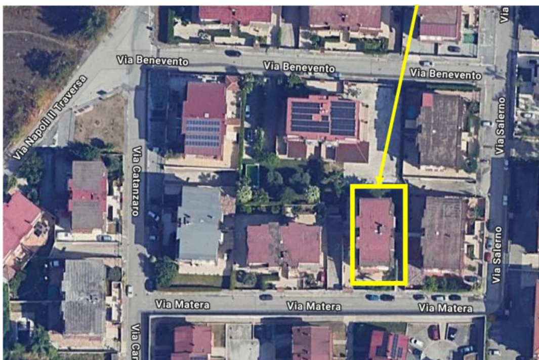
Figura 1 – Foto satellitare e individuazione dell'edificio di cui sono parte i beni pignorati.
