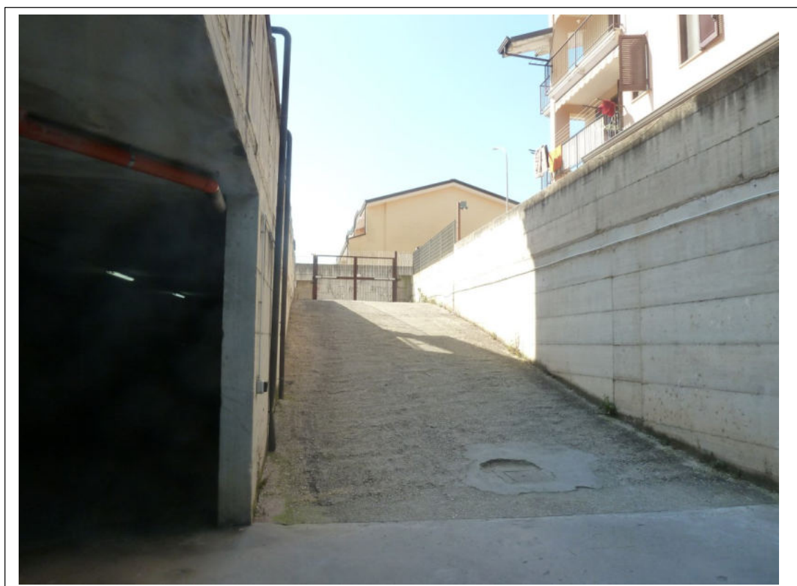
Foto 29 – Rampa di accesso dalla via Matera.
