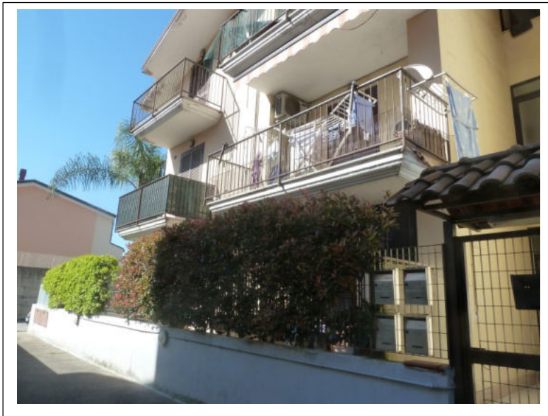
Foto 16 – Balconi dell'appartamento (lato Est)
