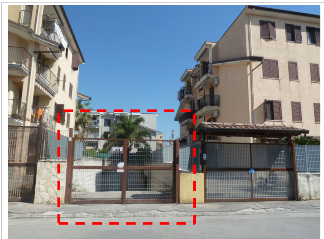
Foto 27 – Cancelli di accesso alla rampa che conduce al piano interrato S1 ove è il box-auto.
