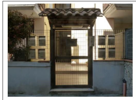
Foto 3 – Ingresso alla “Scala G” di cui è parte il bene pignorato.
