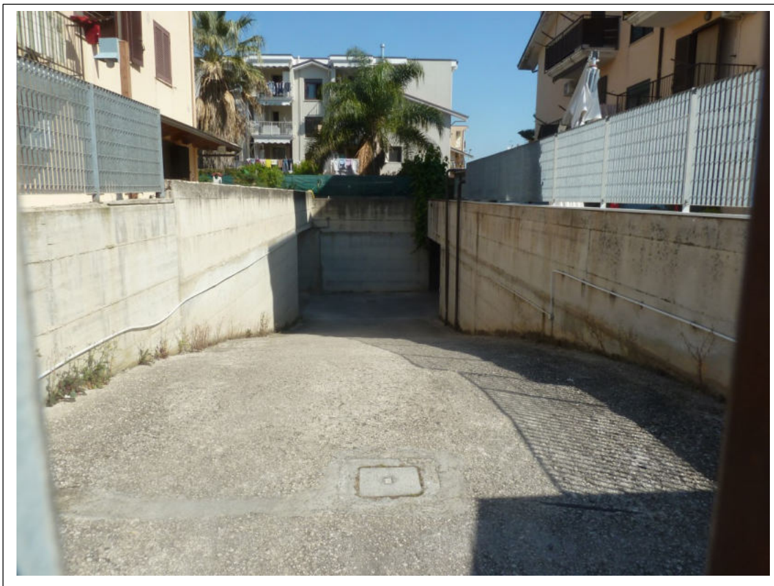
Foto 28 – Rampa di accesso al piano interrato ove è il box auto.
