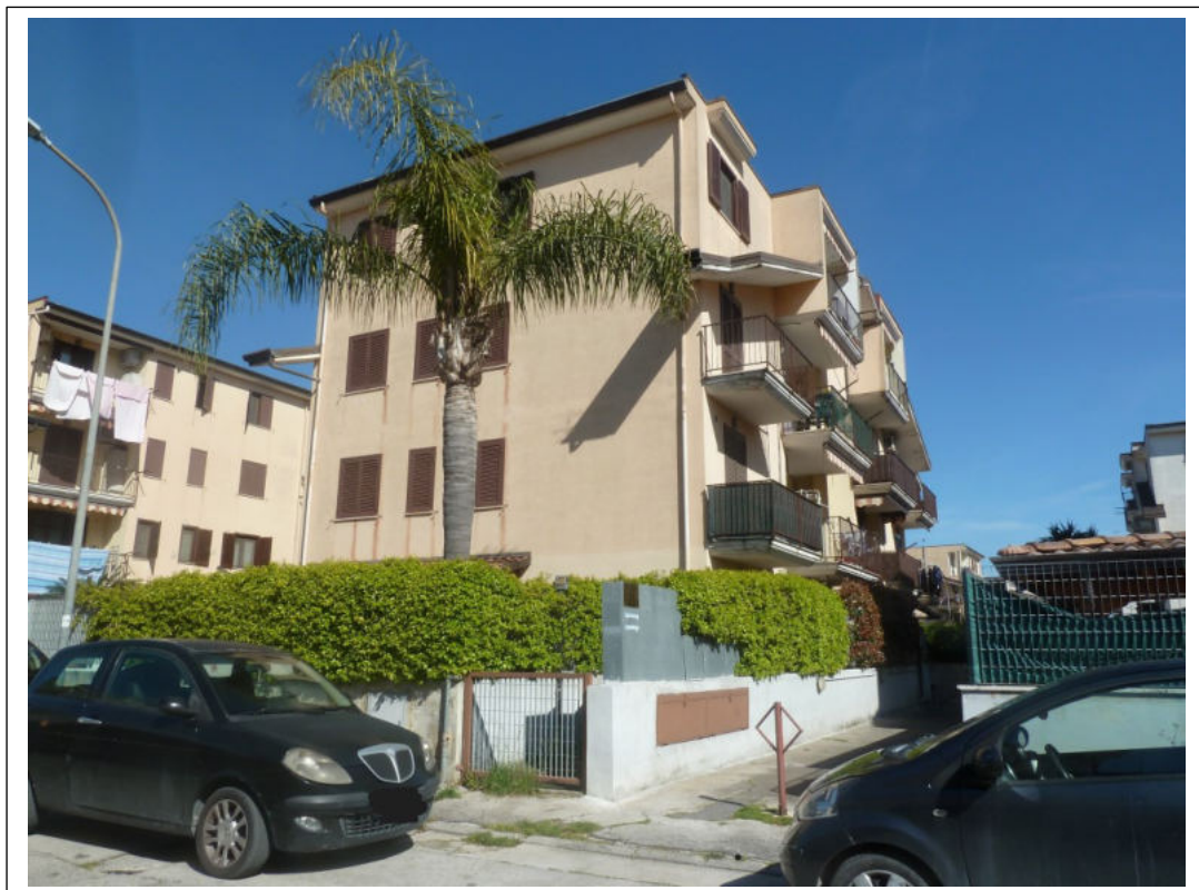
Foto 26 – Vista della “Scala G” del Parco S. Chiara.
