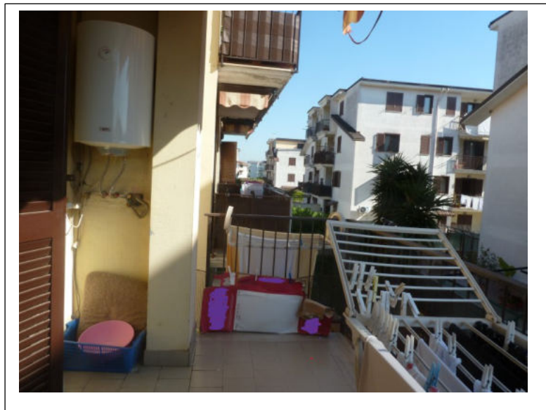
Foto 17 – Balcone della cucina.
