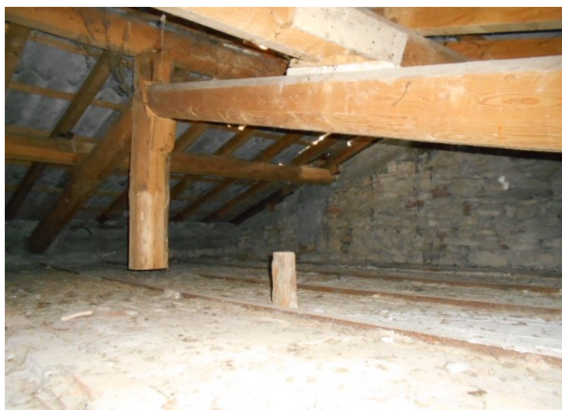
l'intradosso della copertura
