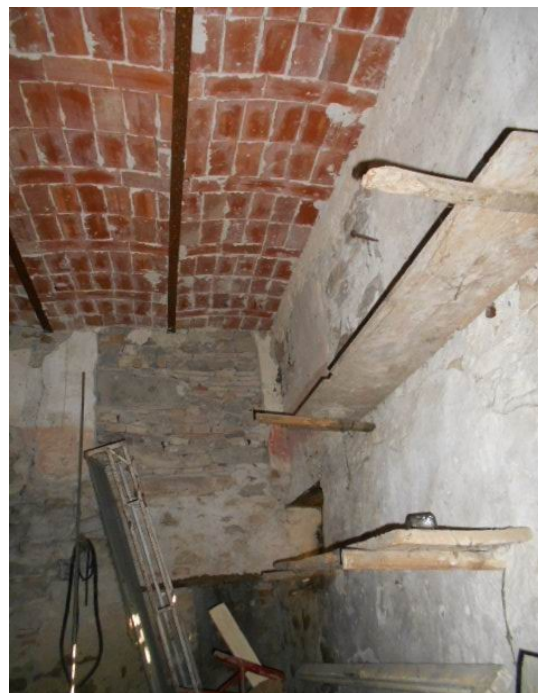
scantinato e intradosso del solaio di primo piano
