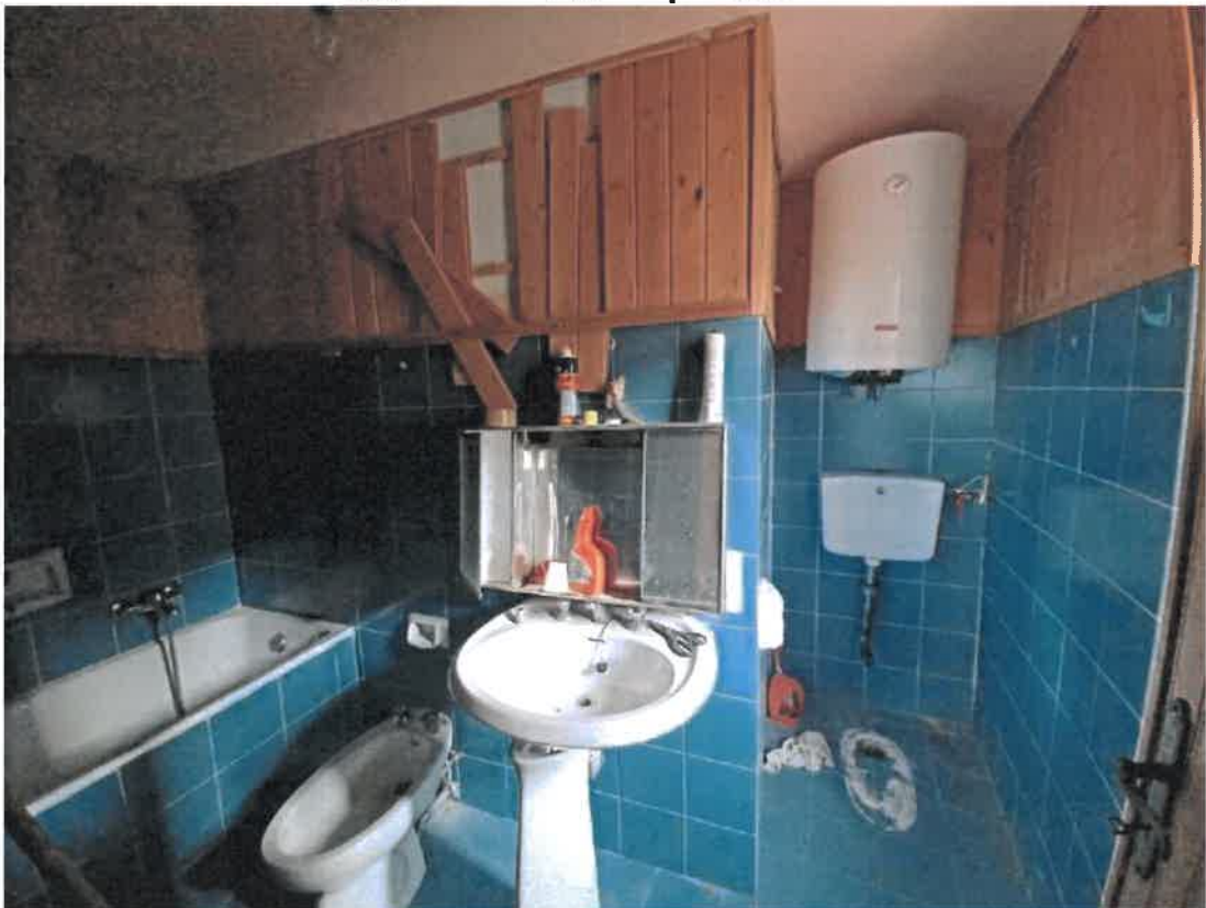
Vista interna – Bagno piano secondo
