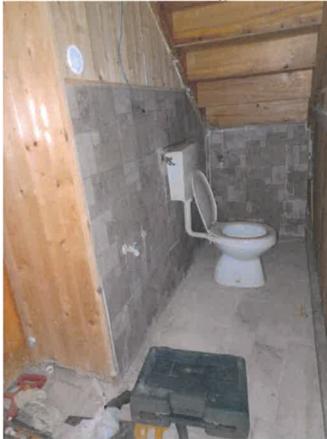
Piano terra – Sottoscala
