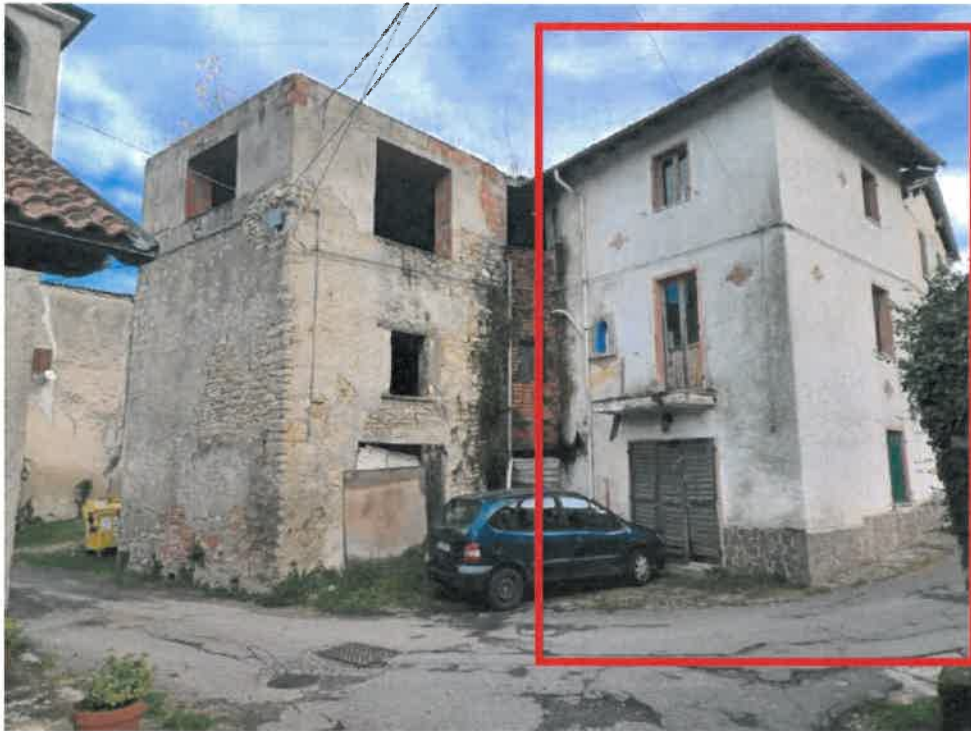
Vista generale dalla viabilità comunale
