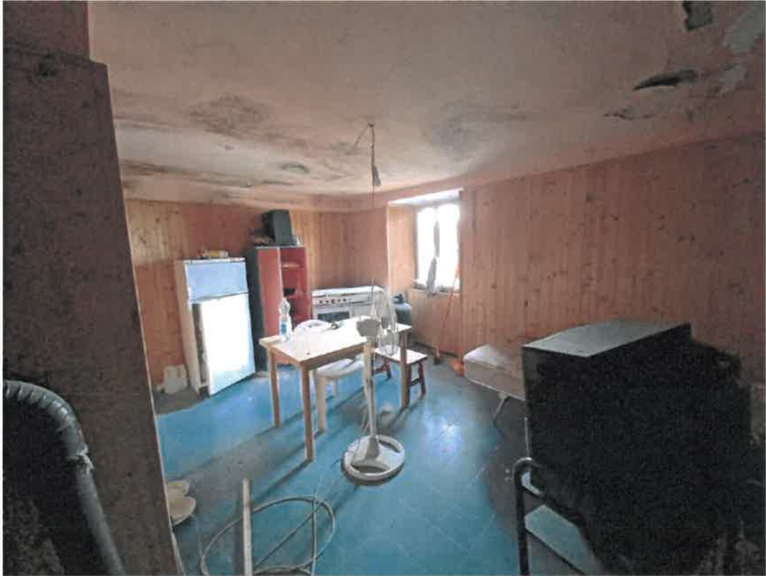
Vista interna – Camera piano secondo
