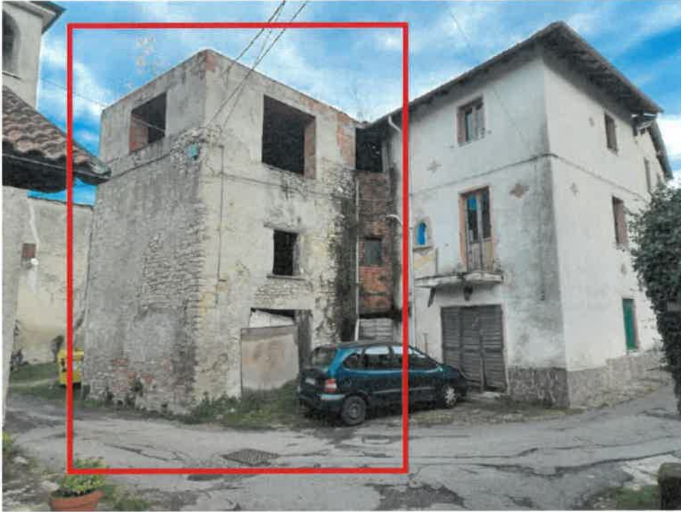
Vista generale dalla viabilità comunale
