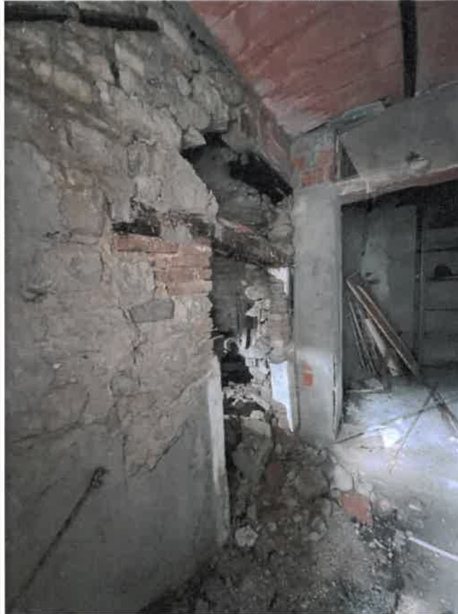
Vista interna – Disimpegno piano terra
