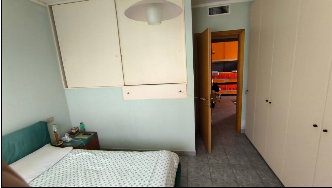
Figura 26: Vista interna del solaio della Camera 09 al piano primo.
