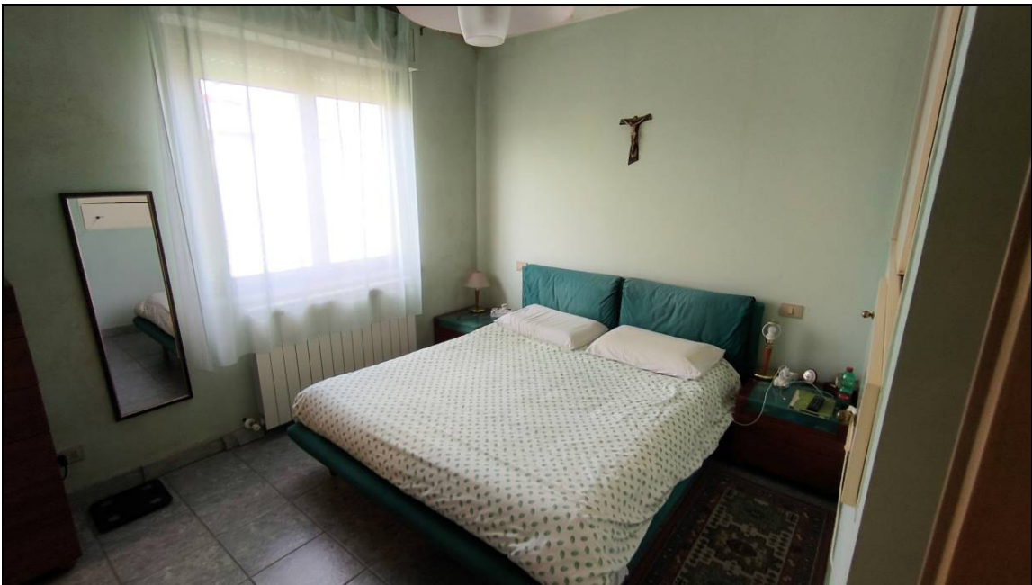
Figura 25: Vista interna del solaio della Camera 09 al piano primo.
