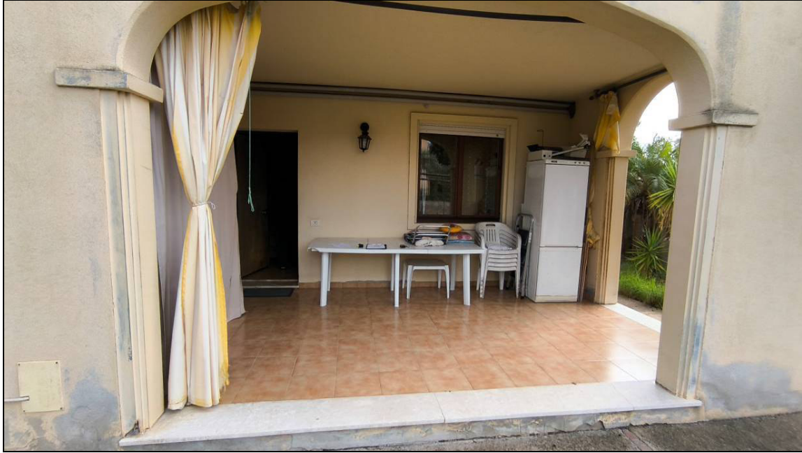
Figura 11: Vista della Veranda al piano terra da cui si accede agli ambienti interni dell'unità immobiliare.
