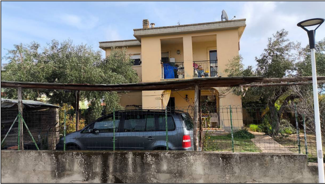
Figura 3: Vista dell'unità immobiliare dalla Via Aniense
