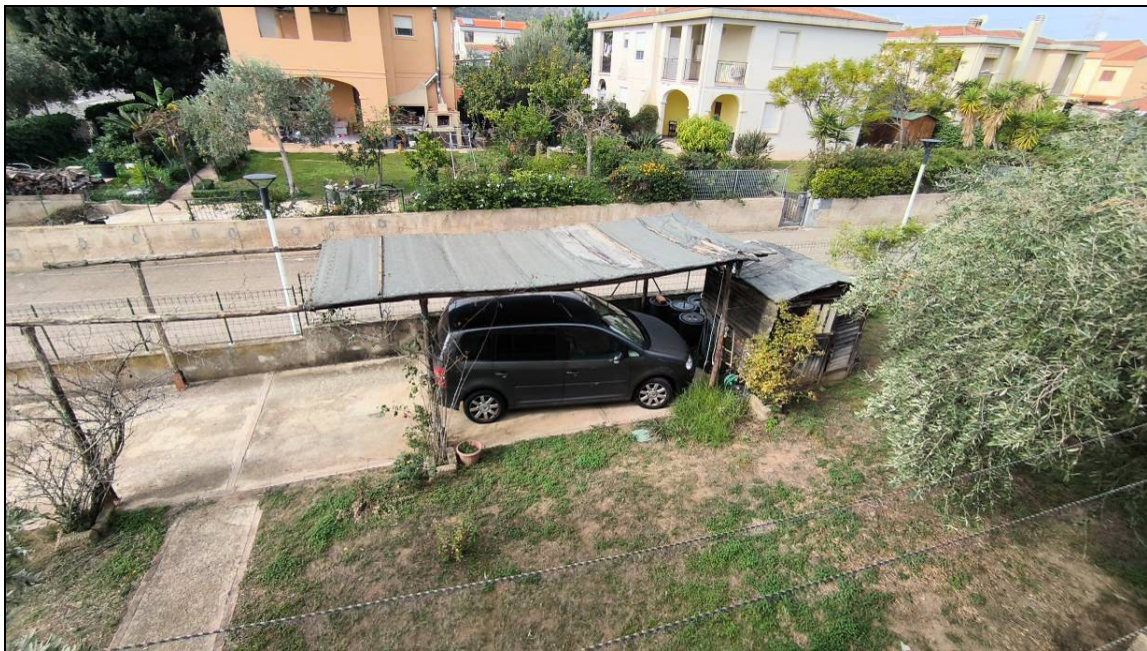
Figura 10: Vista del deposito attrezzi e della tettoia realizzati in difformità dallo stato di diritto.
