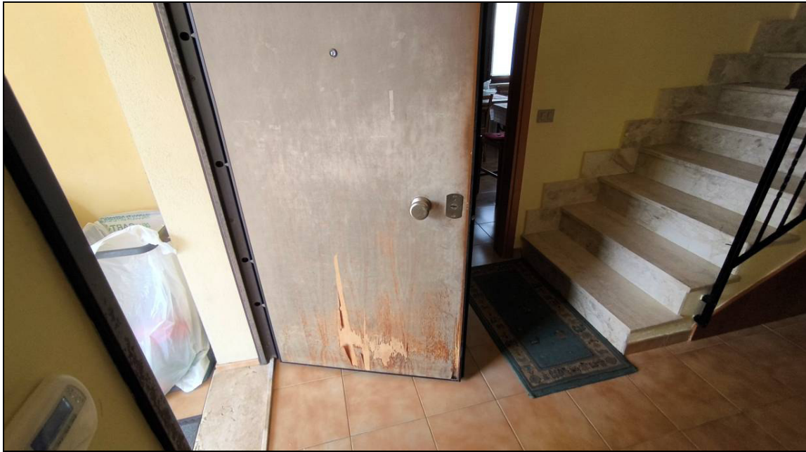
Figura 12: Vista del portoncino di ingresso.
