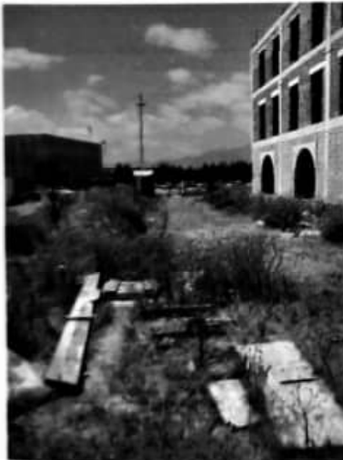
Foto n° 6 - Vista prospetto lato Lotti nn°1-2
