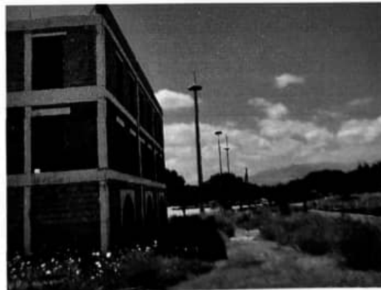
Foto n°7 - Vista prospetto lato proprietà privata
