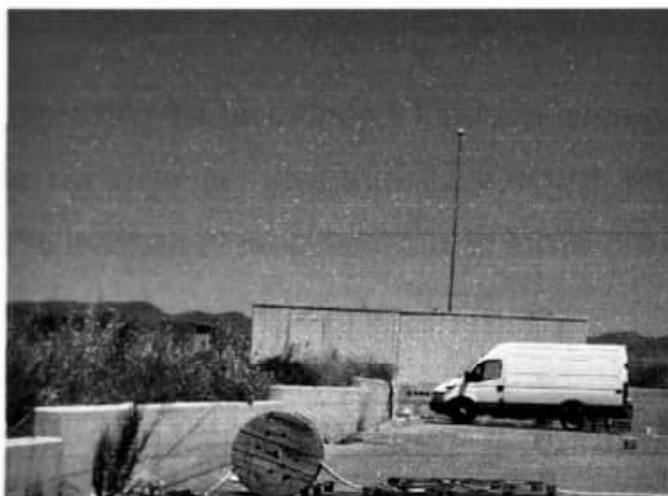
Foto n°13 - Particolare cabina elettrica
