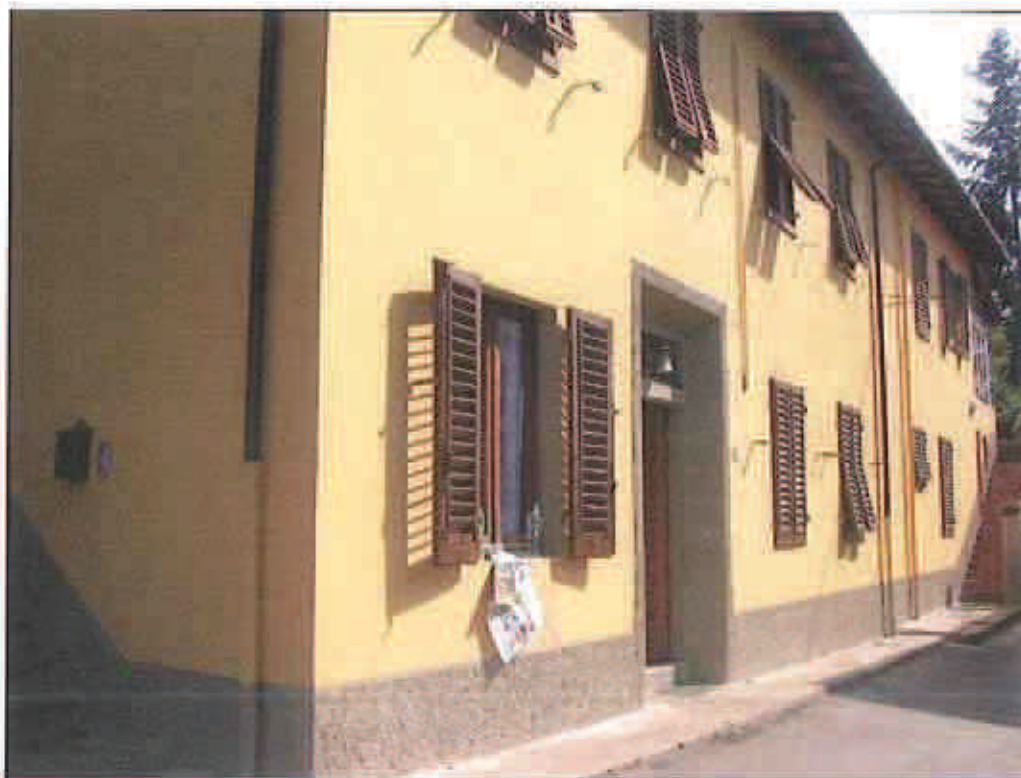
Fotografia 43: Bene 5 – Vista del fabbricato
