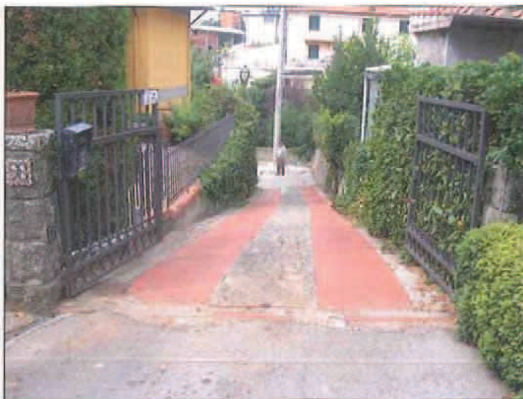
Fotografia 29: Bene 3 – Rampa d'ingresso dalla via
