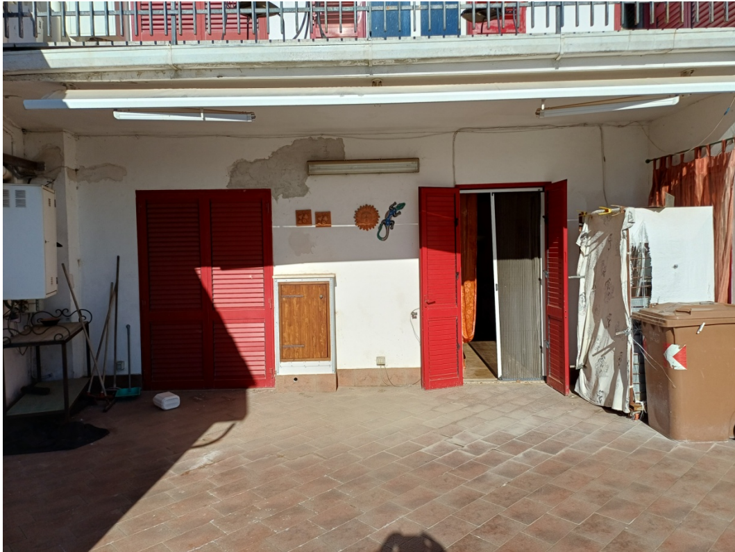
FOTO N°3 – vista della parete esterna del soggiorno dal terrazzo lato S-O
