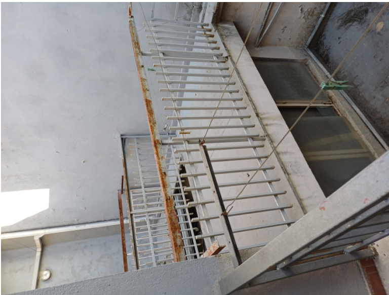
FOTO N. 16 – aree pavimentate poste sul retro
