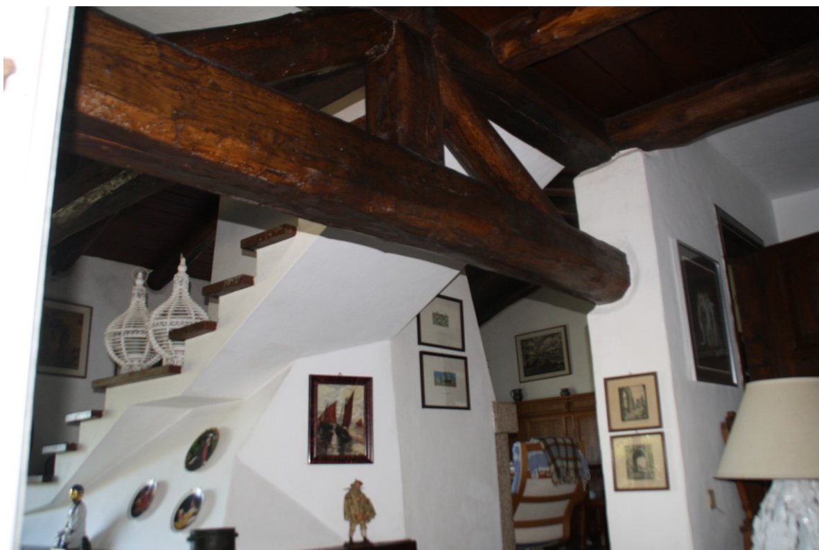
Foto 25 Particolare capriata tetto
