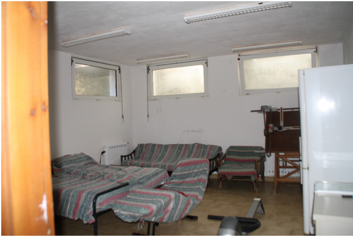
Foto 44– Locale seminterrato ad uso ufficio
