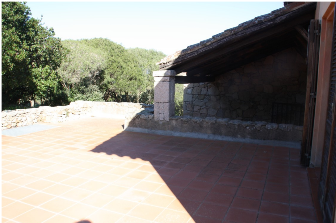
Foto 12 Ripresa lato sud – terrazza camera da letto padronale
