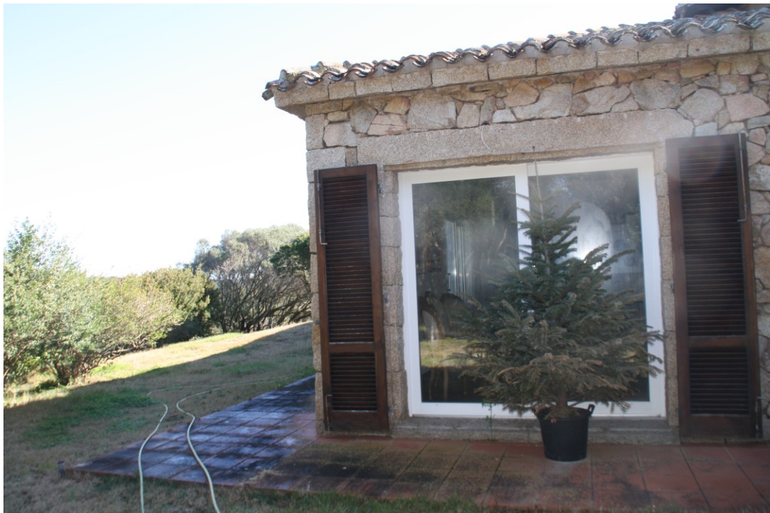
Foto 05 Ripresa lato ovest - Vetrata soggiorno
