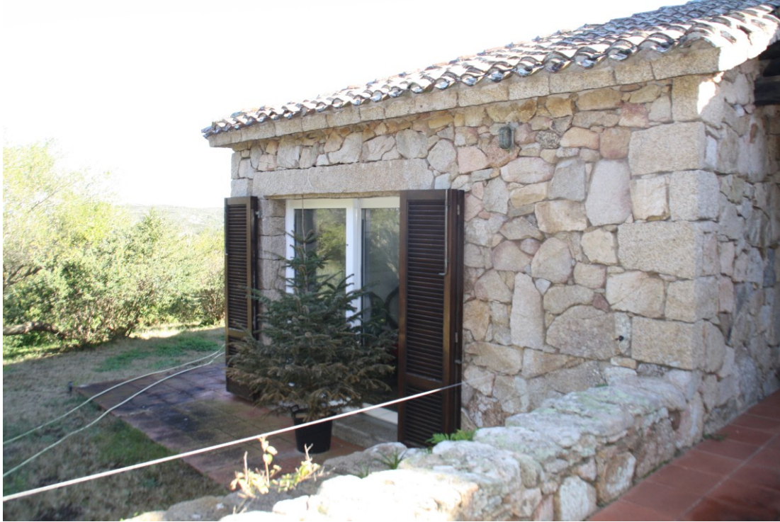
Foto 05 Ripresa lato ovest
