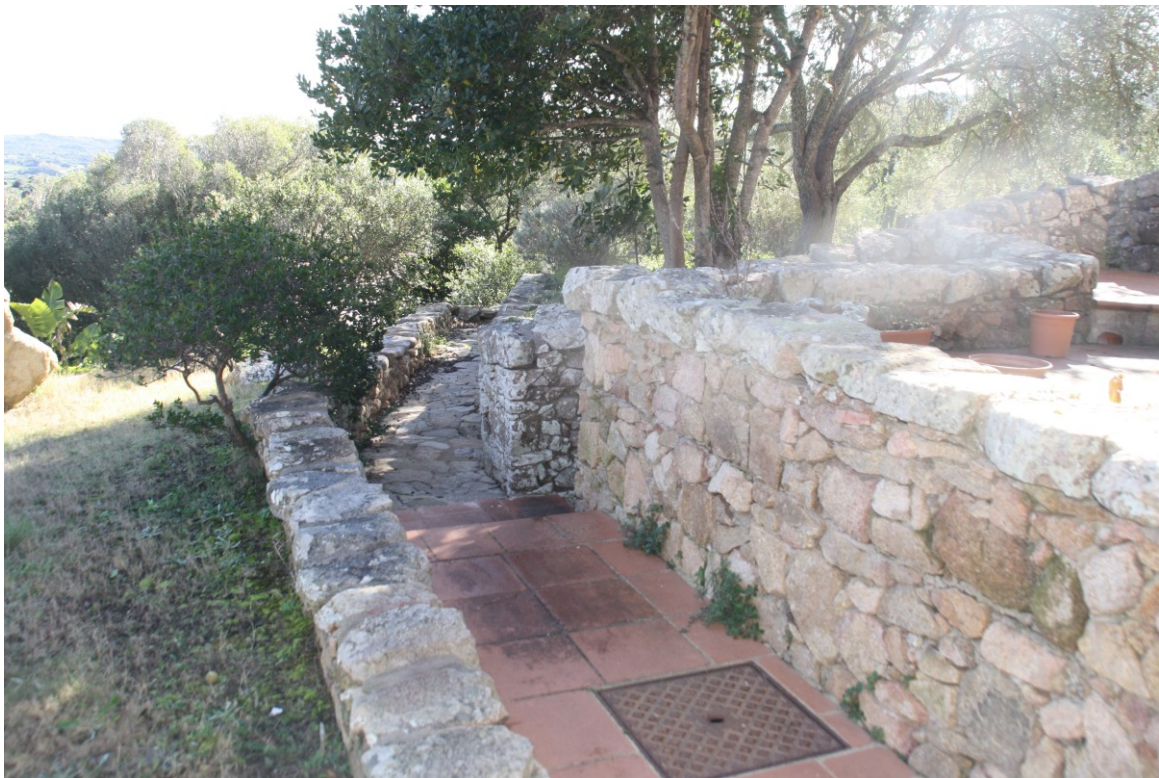
Foto 09 Ripresa lato nord- Camminamenti
