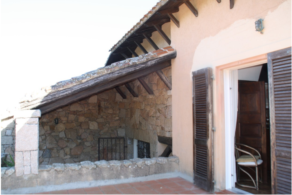
Foto 13 Ripresa lato sud – terrazza camera da letto padronale
