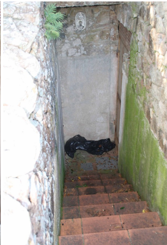
Foto 15 Accesso vano tecnico lato est
