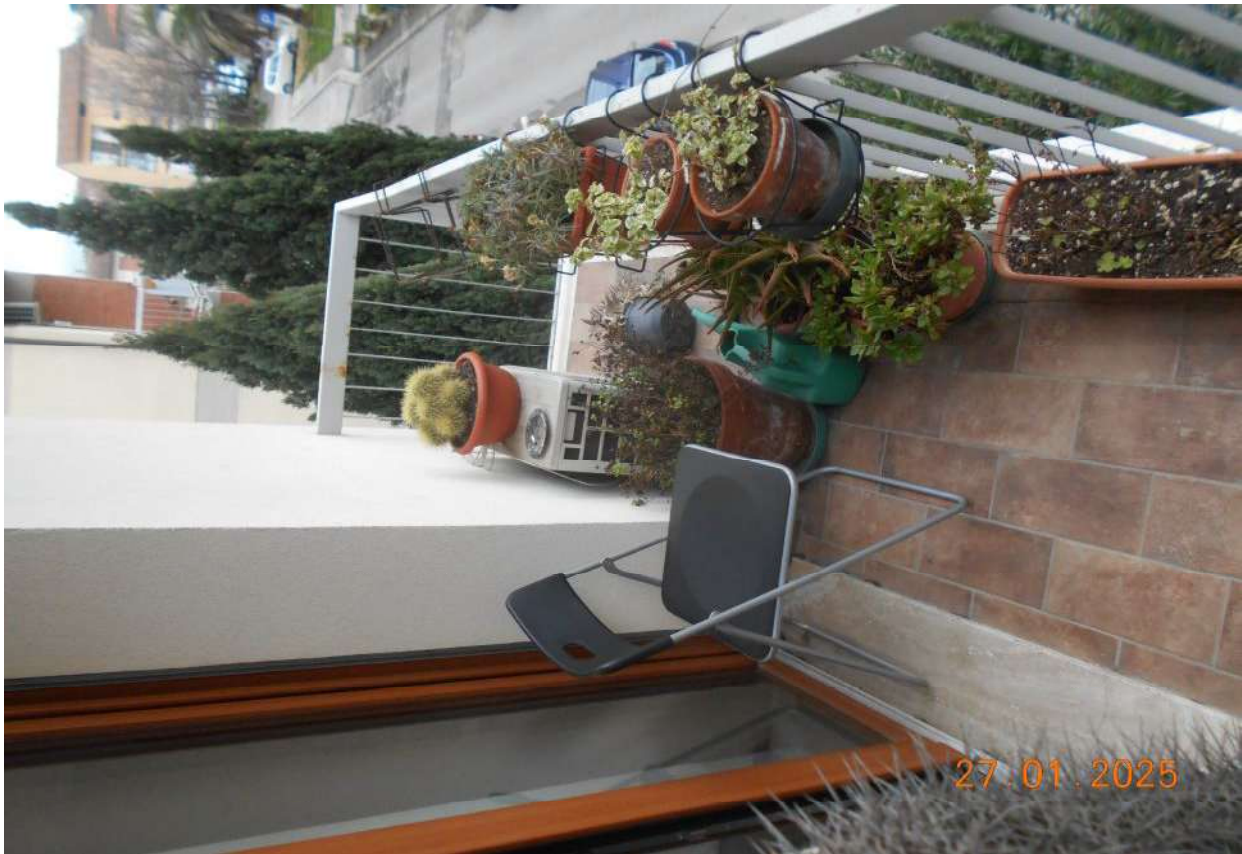
Foto n° 11 Terrazza su facciata principale
