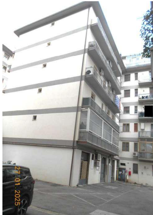
Fotografia n° 2 Facciata laterale e tergale
