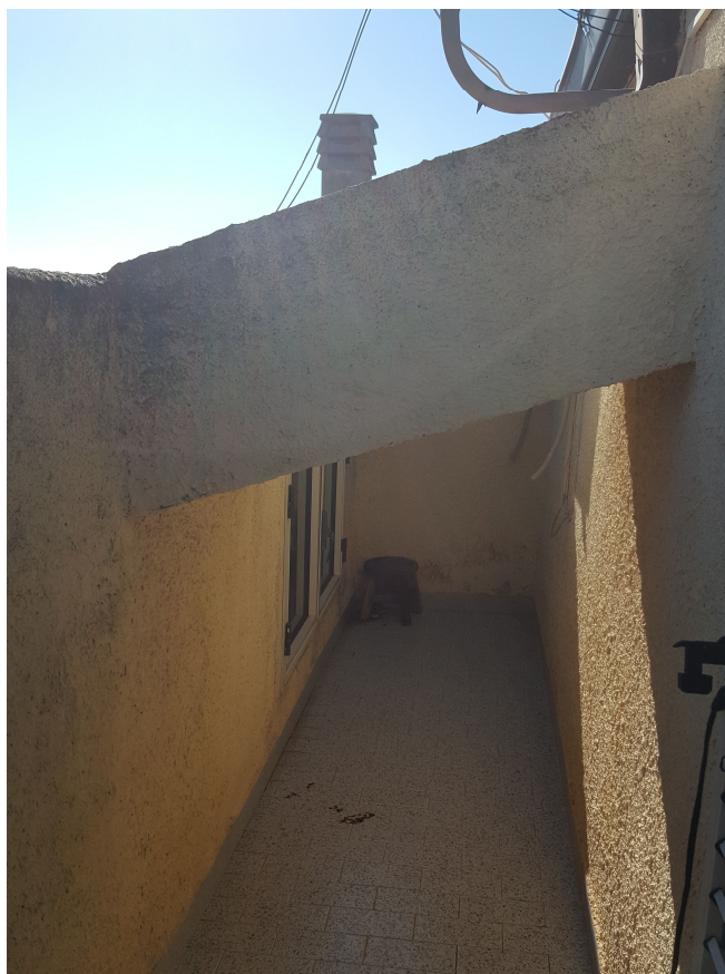
Balcone lato Est
