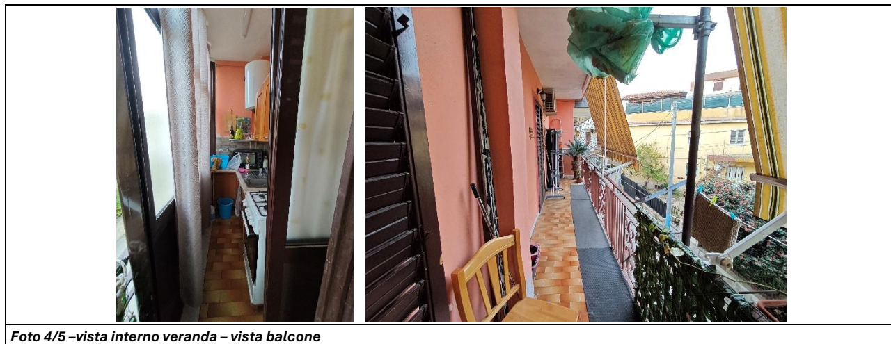
Foto 4/5 - vista interno veranda - vista balcone
