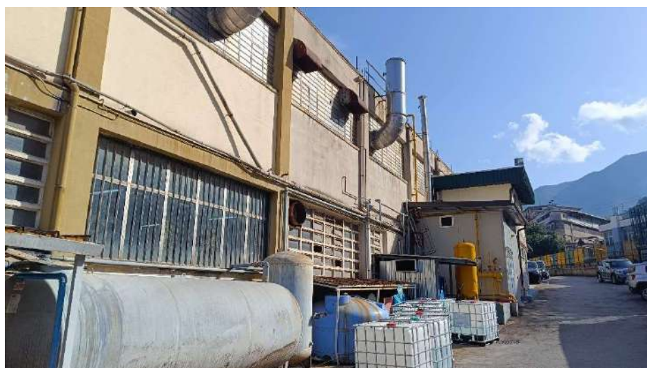
Lato Sud - Locali impianti
