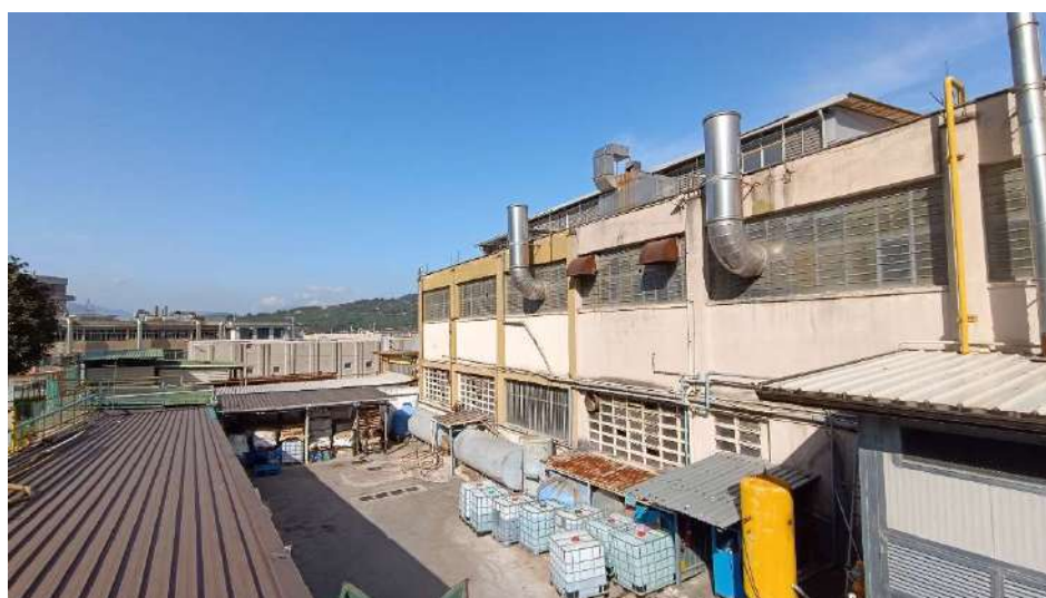
Lato Sud - Locali impianti
