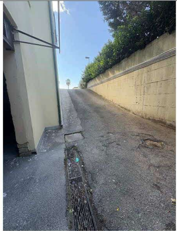
Fotografia n. 4 _ Rampa comune di ingresso al piano interrato
