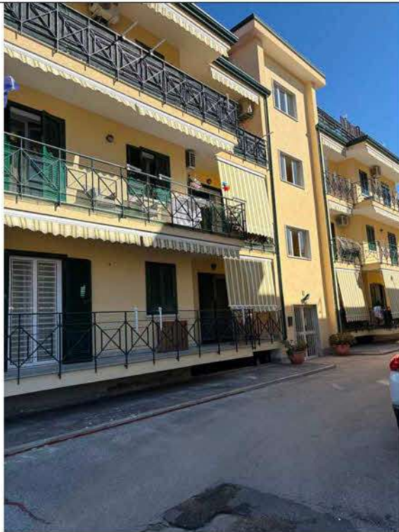
Fotografia n. 1 _ Prospetto del fabbricato sull'area comune
