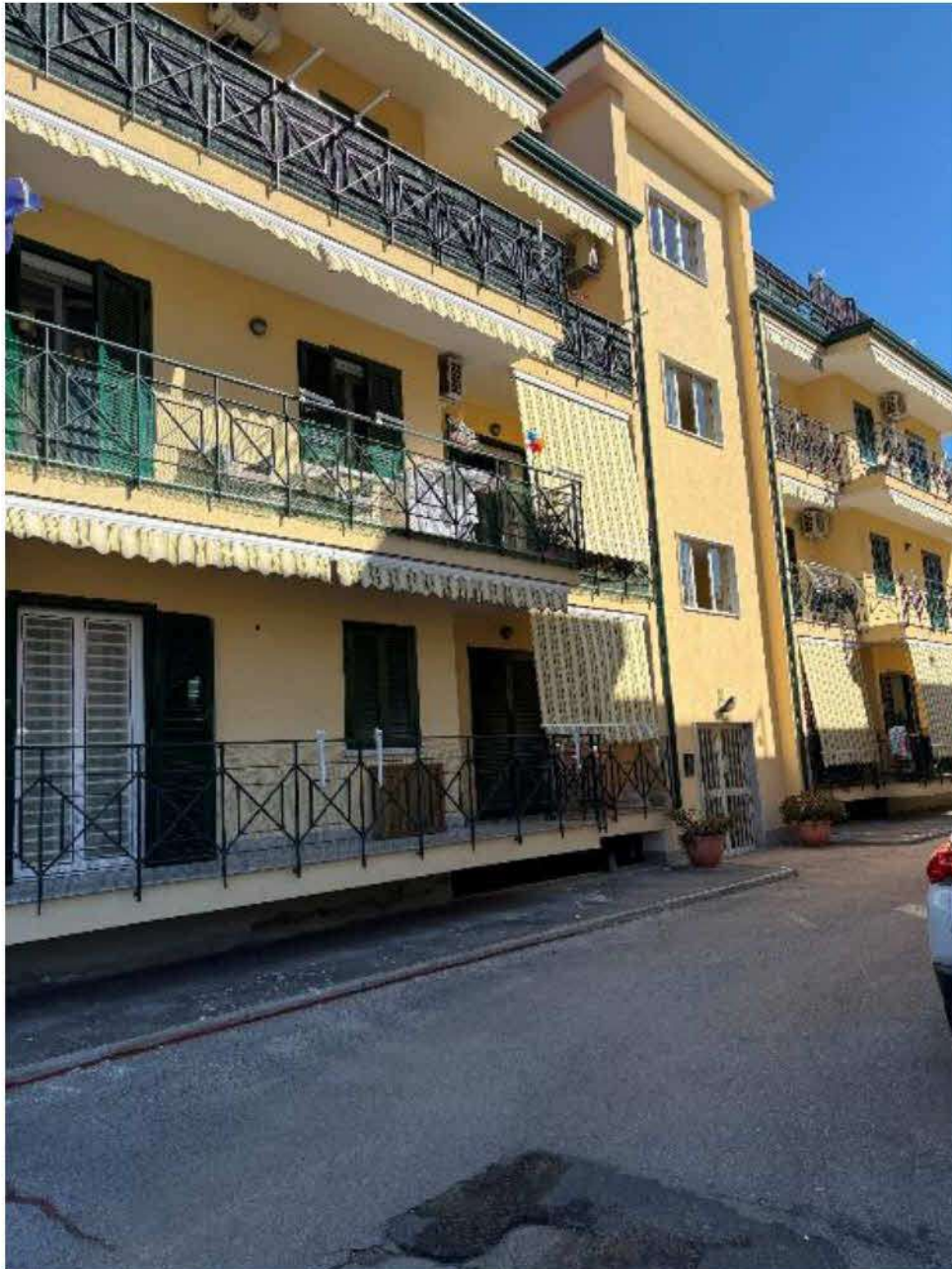
Fotografia n. 1 _ Prospetto del fabbricato sull'area comune
