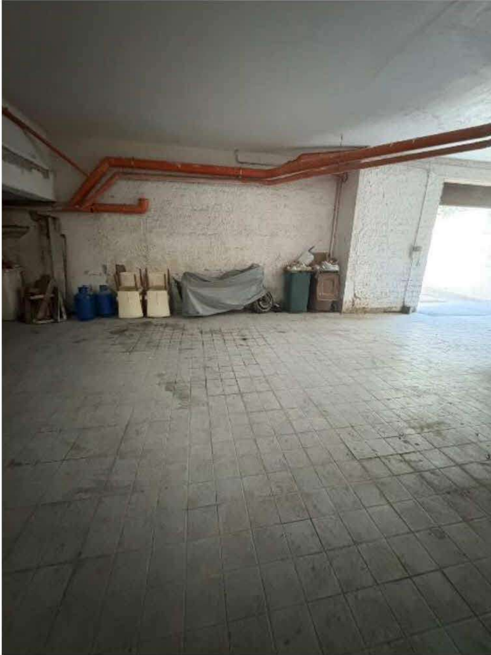
Fotografia n. 12 _ Posto auto al piano interrato
