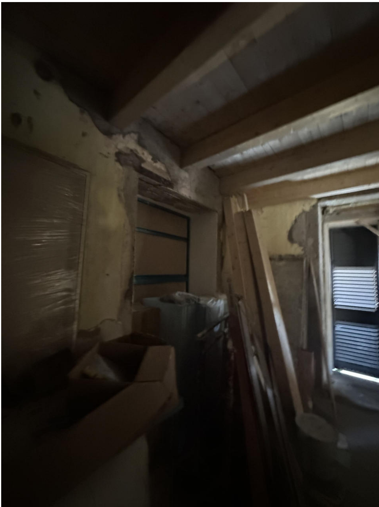
Foto 7: Vista lotto 002 con accesso chiuso al secondo vano piano terra
