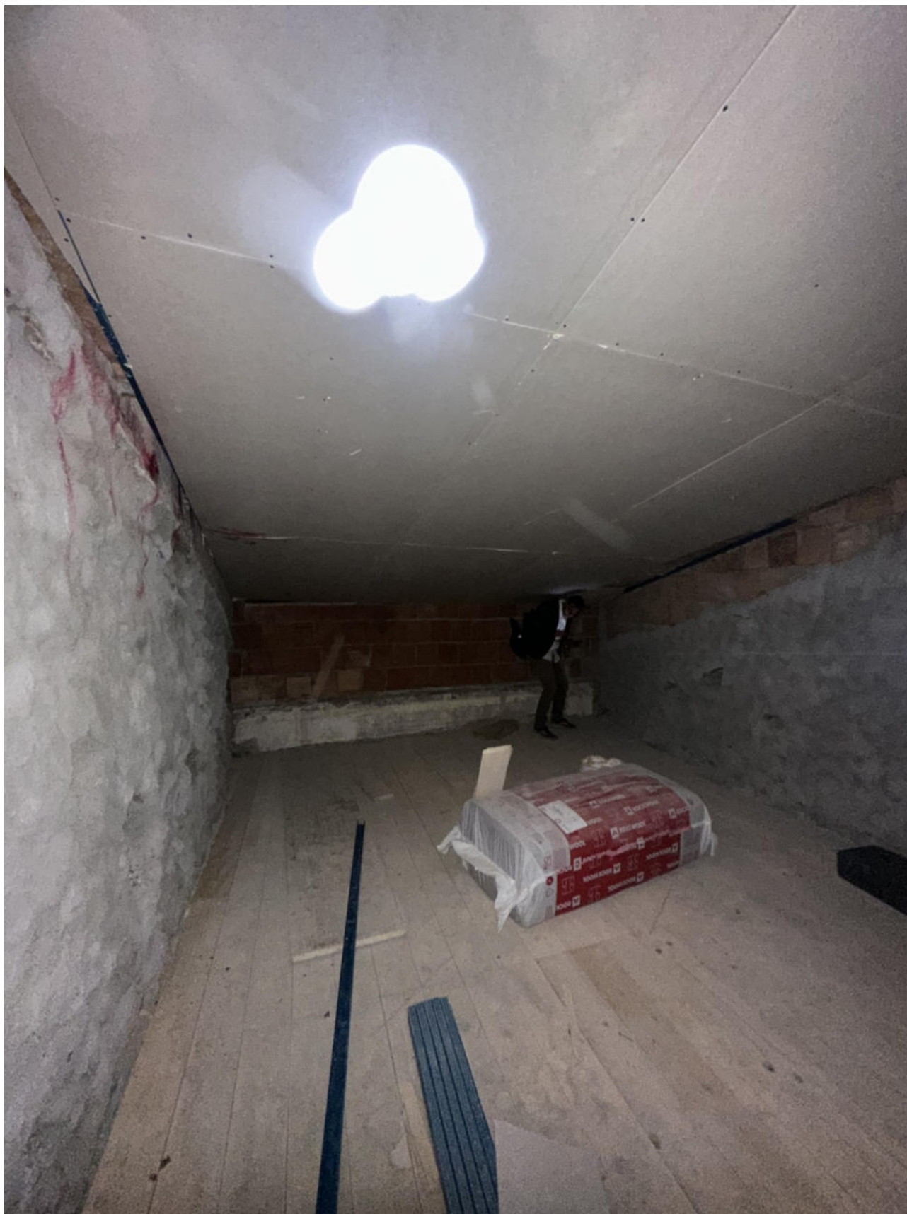
Foto 11: Vista vano soffitta piano primo
