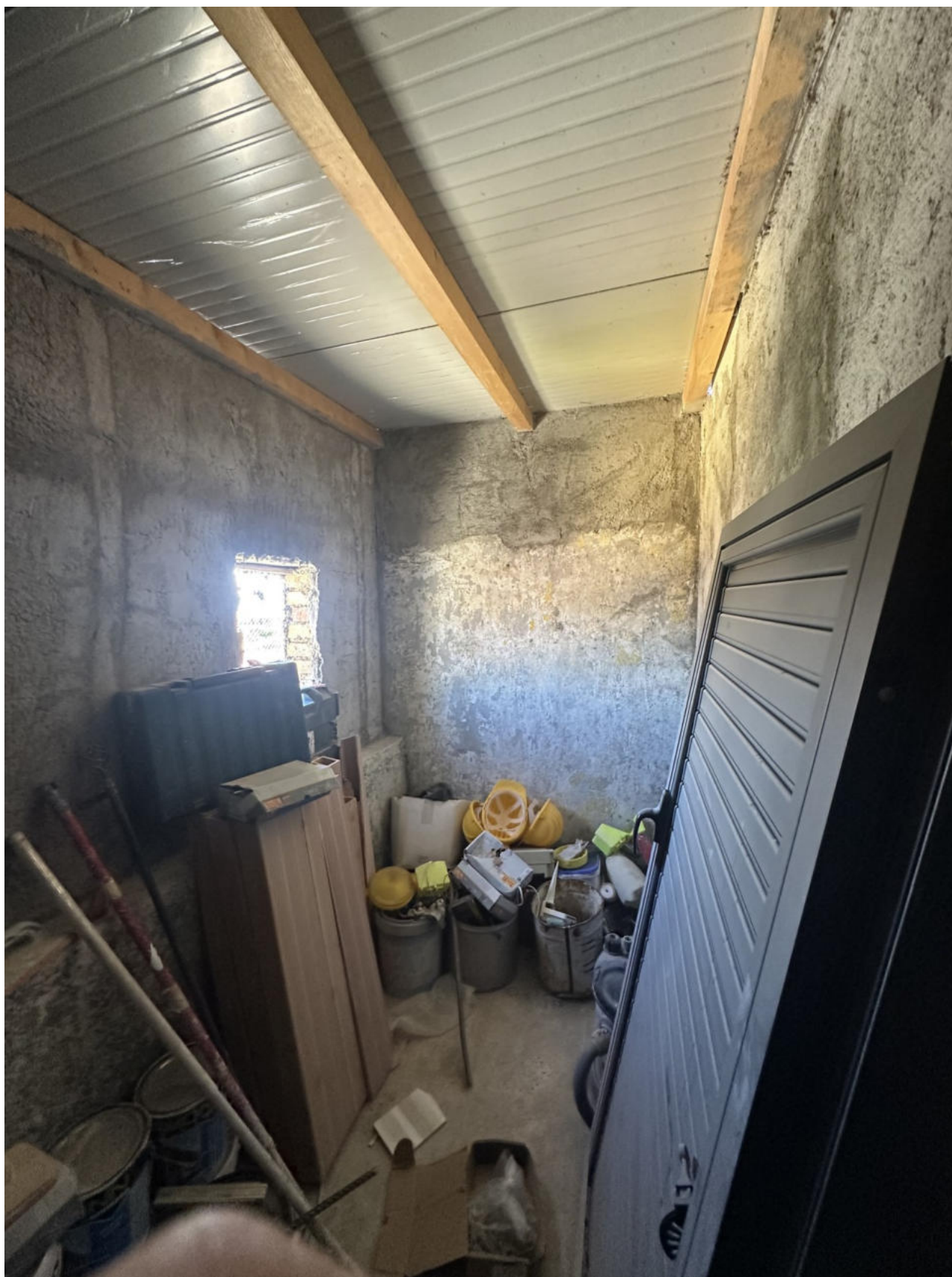
Foto 8: Vista balcone esterno coperto
