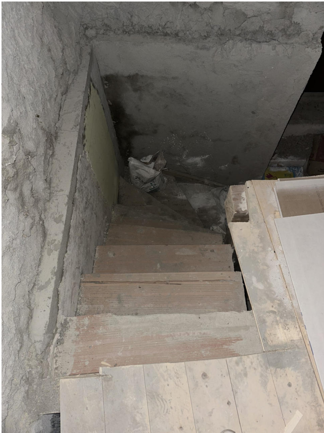
Foto 9: Vista scala vano piano terra
