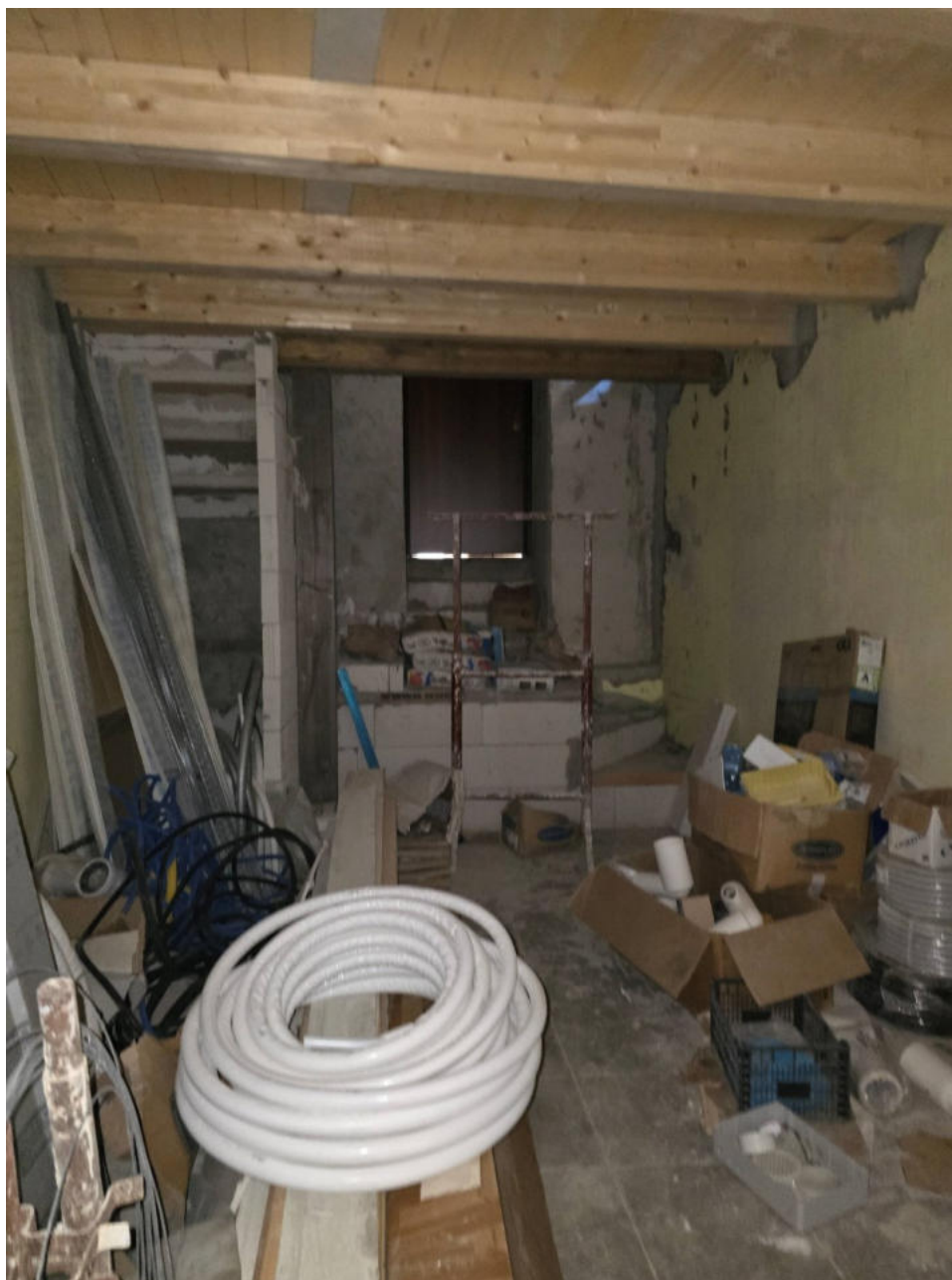
Foto 10: vista scala di collegamento
