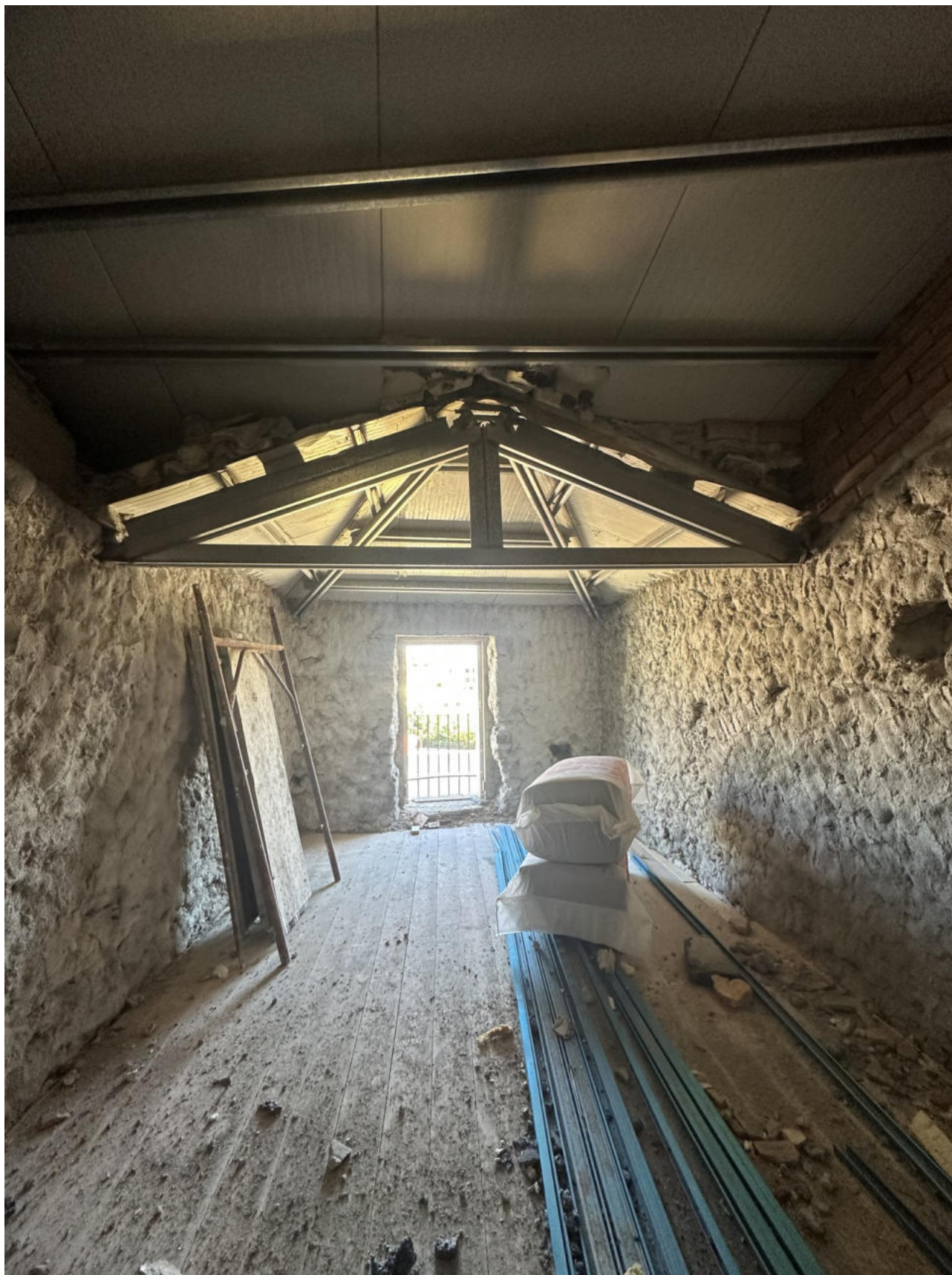
Foto 12: Vista secondo vano piano primo
