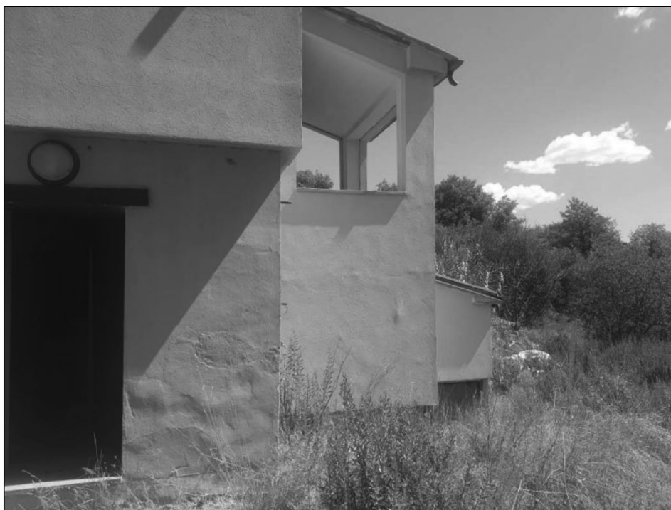
Foto D: Vista n.3 facciata sud-ovest
