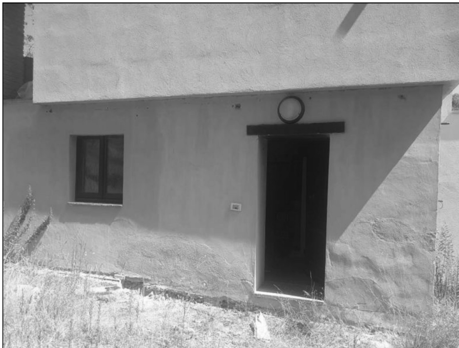
Foto C: Vista n.2 facciata sud-ovest
