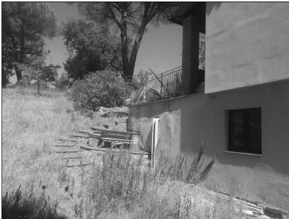
Foto B: Vista n.1 facciata sud-ovest
