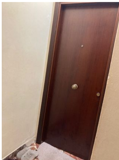
Foto n. 6 ingresso primo piano
