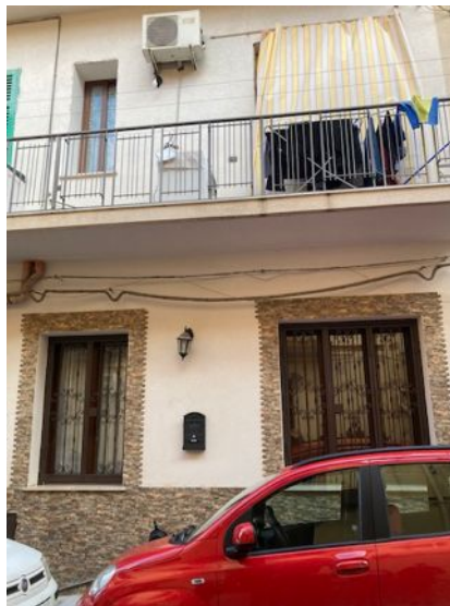
Foto n. 2 prospetto fabbricato su strada
