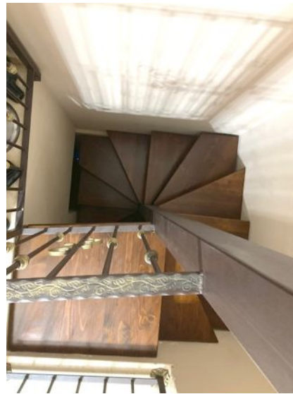
Foto n. 12 scala di collegamento
