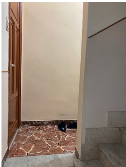
Foto n. 5 pianerottolo di accesso
