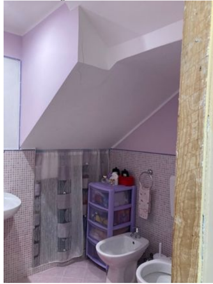
Foto n. 14 wc piano terra
