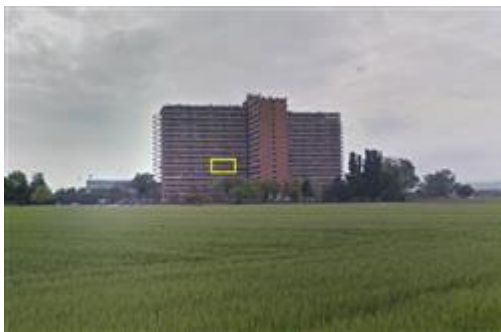
Vista complesso immobiliare lato nord con individuazione della proprietà
