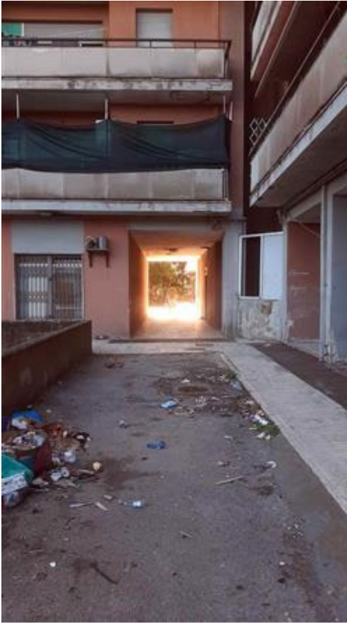
Ingresso scala A - vista dalla corte interna del complesso immobiliare
