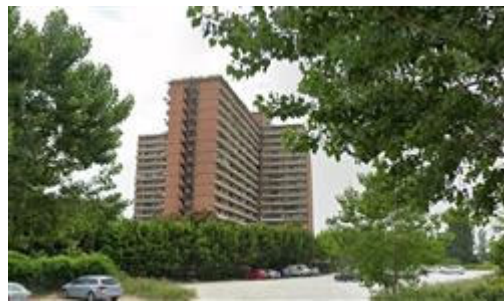
Vista del complesso immobiliare da via Salvo D'Acquisto
