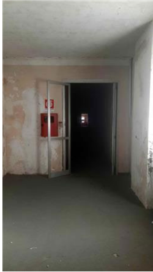
Corridoio interno del piano sesto che conduce all'appartamento
