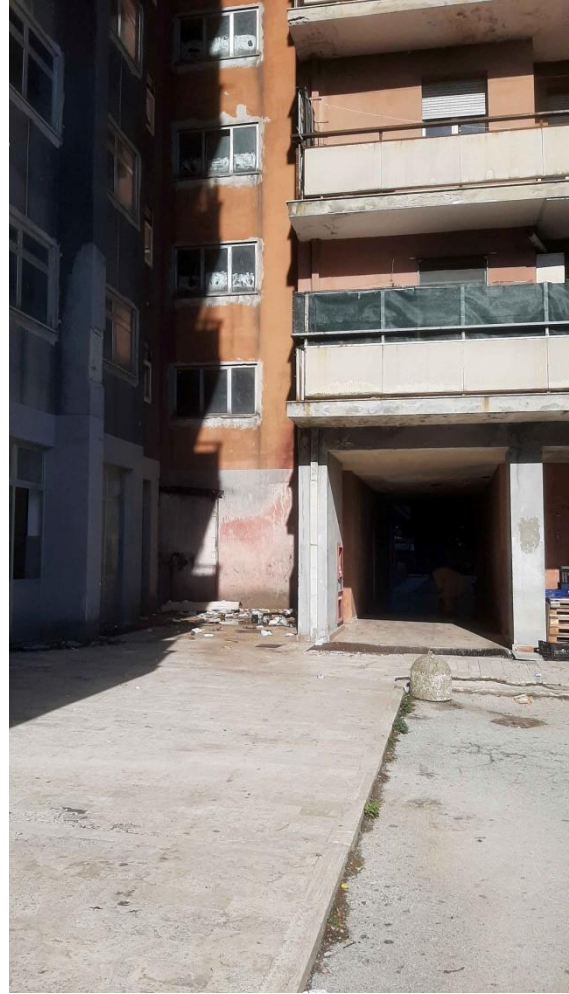
Ingresso alla scala A – dalla corte lato sud
