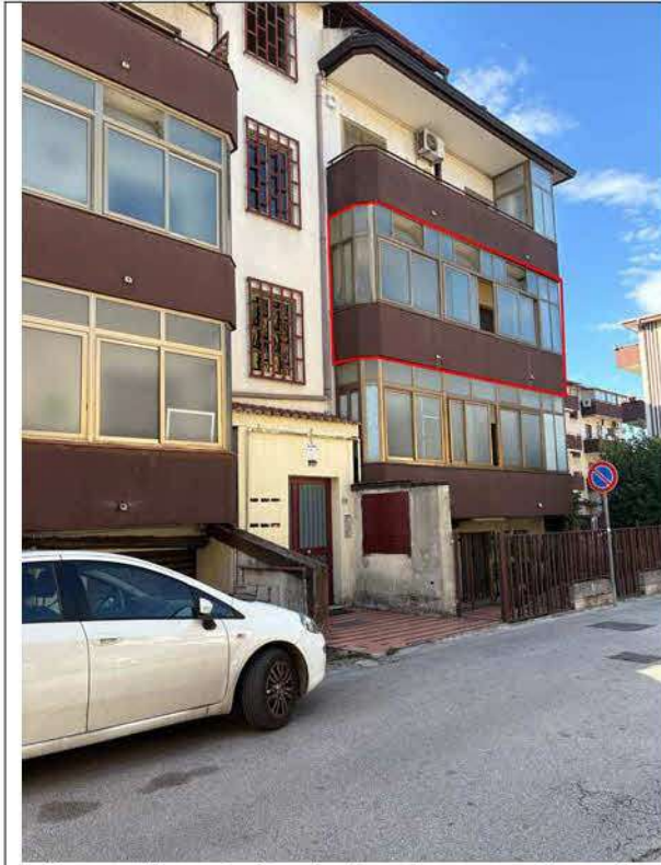
Fotografia n. 3 _ Particolare ingresso alla scala comune e prospetto su via Napoli
