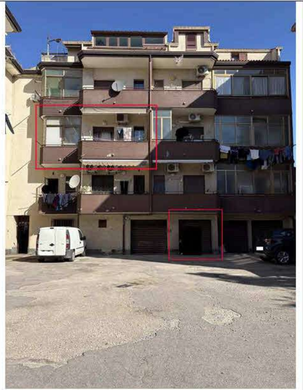
Fotografia n. 4 _ Individuazione dell'appartamento e del box auto sulla corte comune
