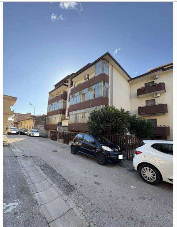
Fotografia n. 2 _ Prospetto del fabbricato su via Napoli, vista ovest/est
