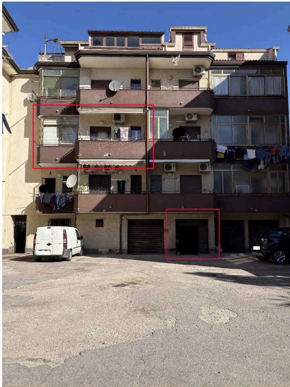
Fotografia n. 4 _ Individuazione dell'appartamento e del box auto sulla corte comune
