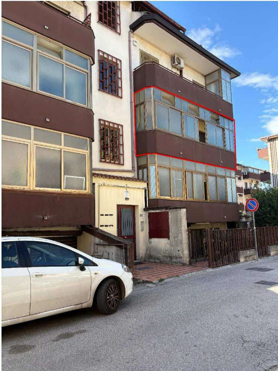
Fotografia n. 3 _ Particolare ingresso e prospetto su via Napoli
