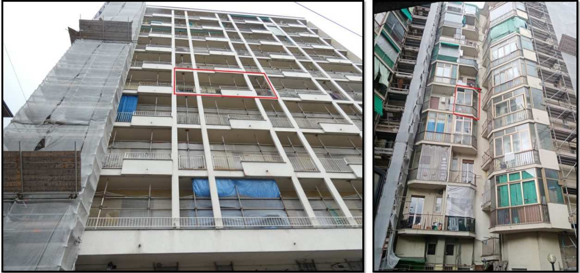
Foto 1 – 2 Stabile fronte su corso Giulio Cesare e prospetto interno cortile condominiale
