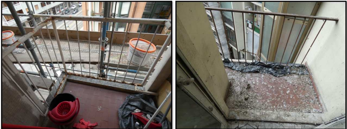
Foto 15 – 16 balconcino su pianerottolo ammezzato
