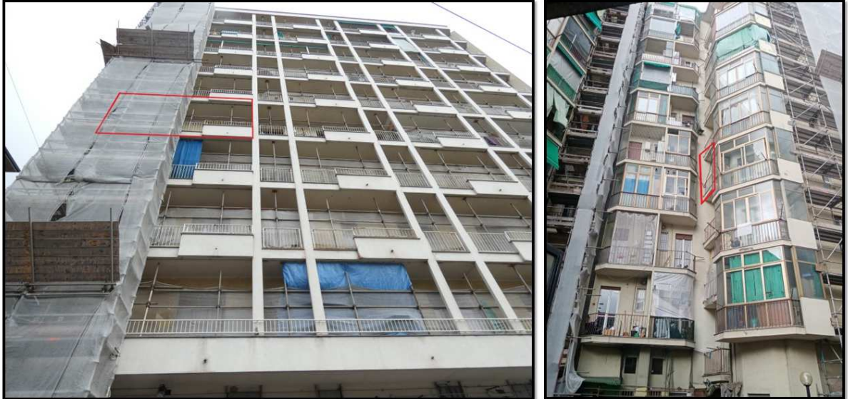
Foto 1 – 2 Stabile fronte corso Giulio Cesare e prospetto interno cortile condominiale
