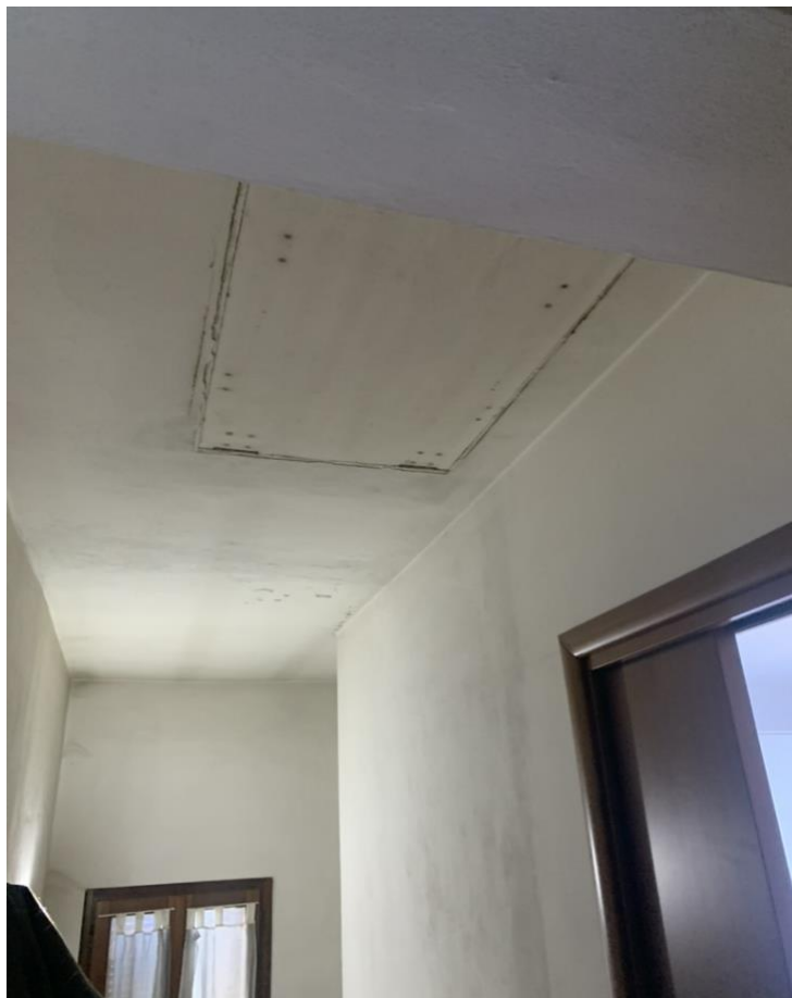
Foto n° 12 – botola nella quale è posta la scala retrattile
