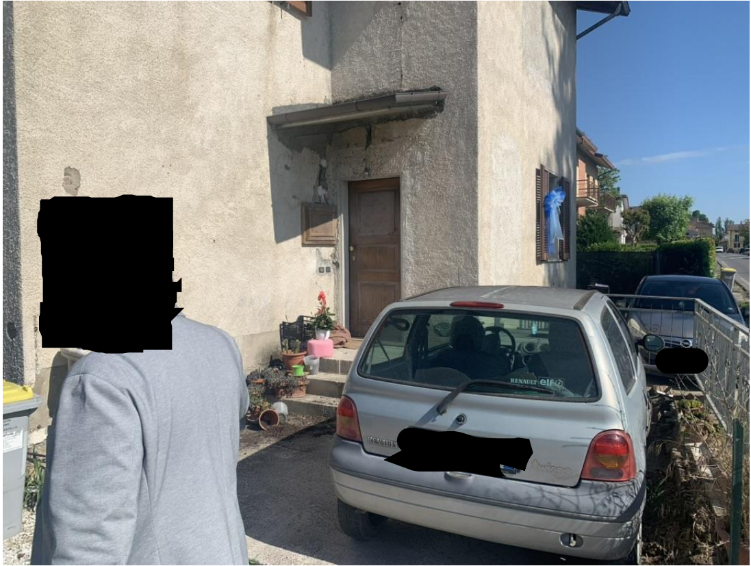
Foto n° 3 – ingresso della palazzina
