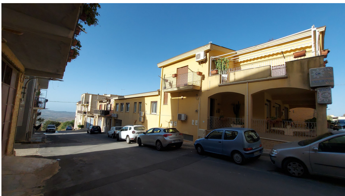
Foto 2 – prospetto laterale su via Colapuma
