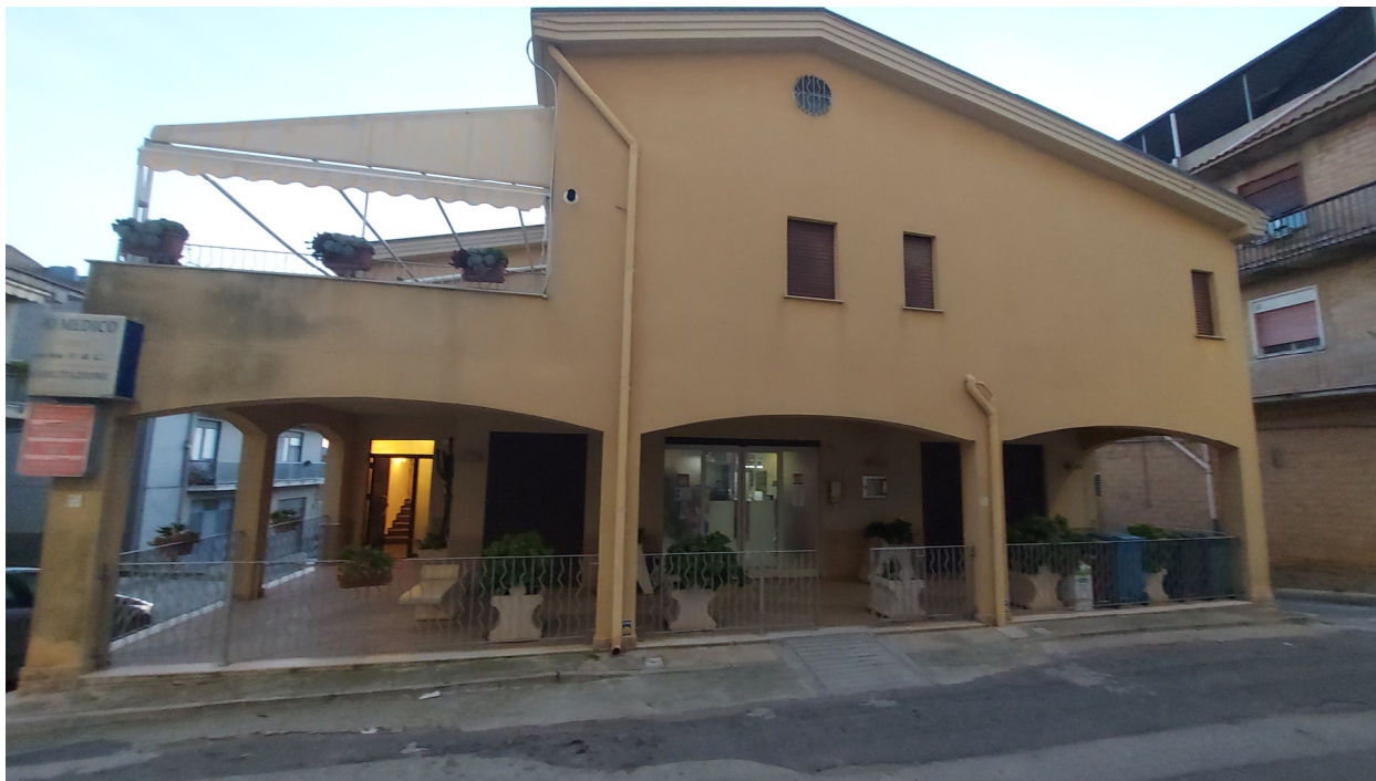
Foto 1 – prospetto principale su via Vittime del Terrorismo, 1 (ingresso abitazione), con portico ad uso comune
