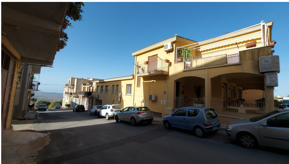
Foto 3 – prospetto laterale su via Colapuma
