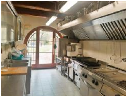
Le cucine (PT): sono suddivise in tre vani allineati; in alto, sono visibili i robusti travi in legno dell'orditura dei solai
