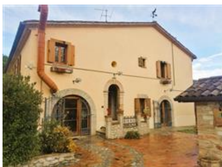
Il dettaglio del prospetto verso la corte, con gli accessi alle cucine e al ristorante (PT), e con la scaletta verso il piano degli alloggi (PI)
