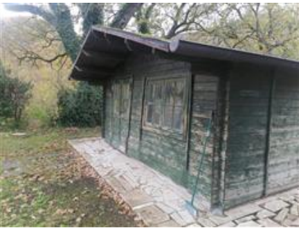
Part. 151 (nello scoperto): il manufatto in legno ad uso deposito attrezzi, di circa 4,80 x 4,80 ml in pianta, destinato alla rimozione
