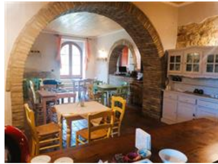
Sala ristorante (PT): gli archi e i materiali scelti (laterizio antico, pietra, coppi, legno nel controsoffitto) e le ampie finestre rendono l'ambiente accogliente e luminoso
