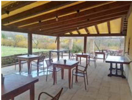
La pergola con struttura in legno e copertura in tela (PGL, nelle consistenze)
