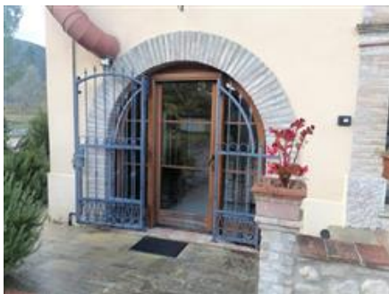
Sub. 1: la portafinestra delle cucine con l'imbotte di pianelle e l'inferriata al posto degli scuroni, rappresentano varianti migliorative
