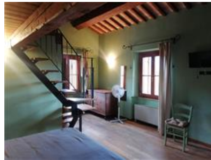
Uno degli alloggi (camera con bagno, al P1): la scaletta ad uso permanente che rende accessibile il soppalco, a sua volta dotato di parapetto
