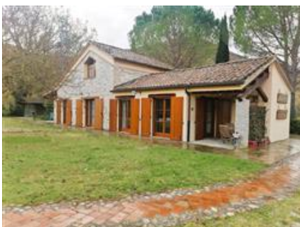
La dépendance (Part. 151), vista dalla corte comune, con il prato e la gradevole pavimentazione esterna per collegamenti pedonali
