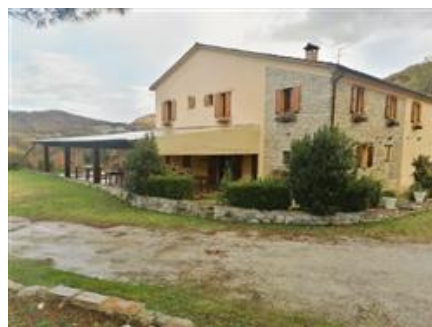
Il fronte verso il viale di accesso, con le aiuole piantumate, i muretti in pietra e pianelle; la pergola è utilizzata per attività correlate alla ristorazione e altre attività stagionali
