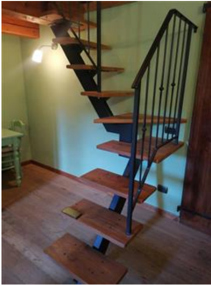
Dettaglio della scaletta, con parapetto, verso uno dei soppalchi non praticabili
