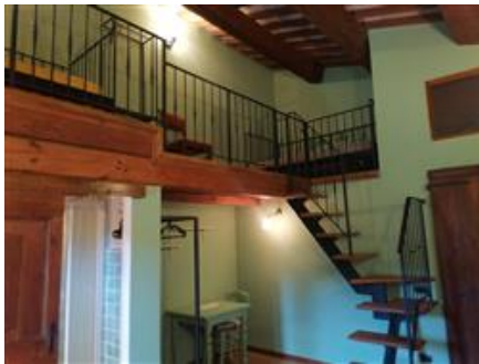
Uno degli alloggi (camera con bagno, al P1): la scaletta ad uso permanente che rende accessibile il soppalco, a sua volta dotato di parapetto
