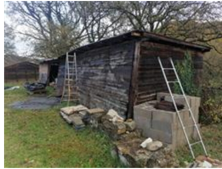
Part. 104 e Part. 63 (?) (terreno): il manufatto in legno ad uso deposito materiali, di circa 15,50 x 4,50 ml in pianta (ACM, nelle consistenze)
