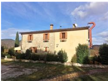
Il prospetto verso la corte, con una parte intonacata e tinteggiata e una parte con pietra a vista; gli scuroni sono in legno; la canna di aspirazione è a servizio delle cucine
