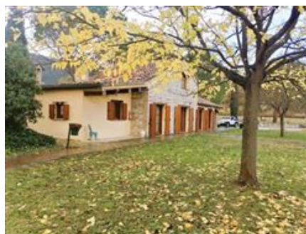
La dépendance, vista dalla corte comune; sullo sfondo, il parcheggio per gli ospiti
