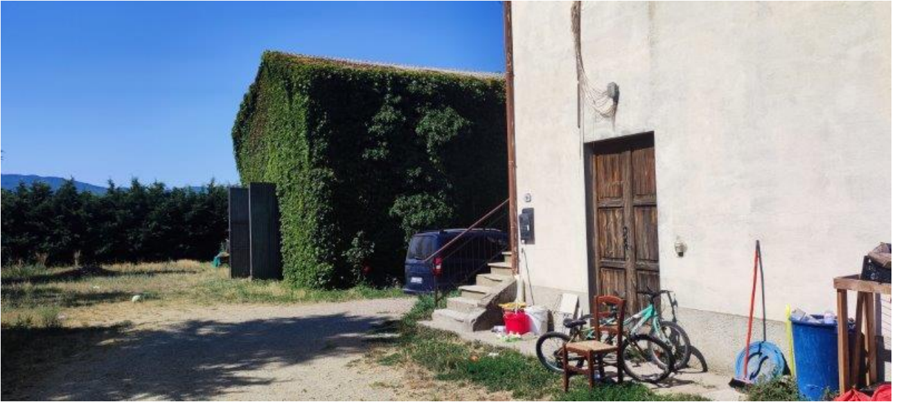
Figura 7 Particolare Fabbricato abitativo e Deposito
