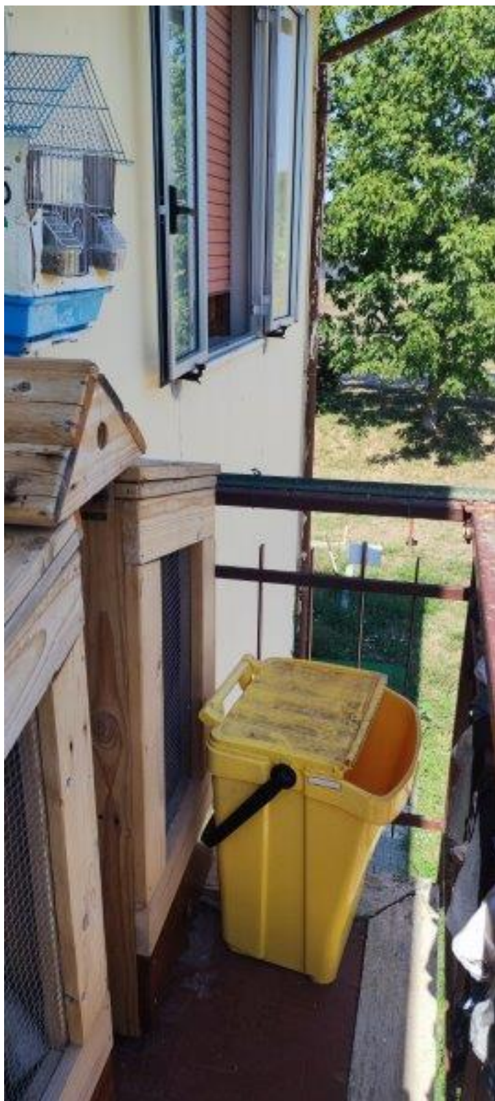
Figura 12 Terrazza fabbricato abitativo n°4
