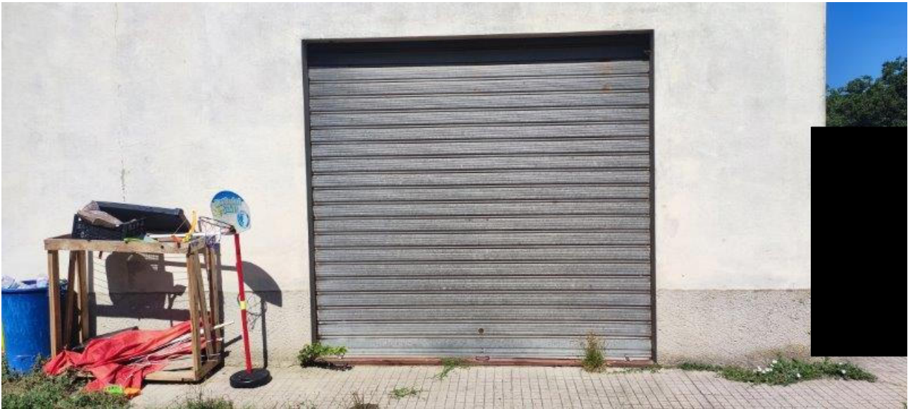
Figura 6 MAGAZZINO - NCEU Comune di Vicchio Foglio 59 Particella 336 sub.2
