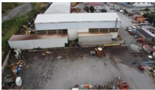
Vista aerea - in primo piano i corpi aggiunti senza autorizzazione
